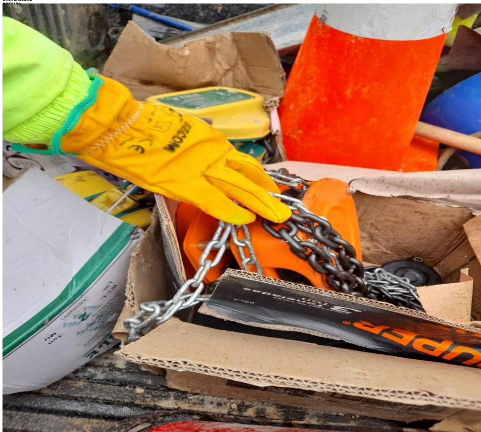
Foto 05. Inspecciones de las herramientas, equipos
