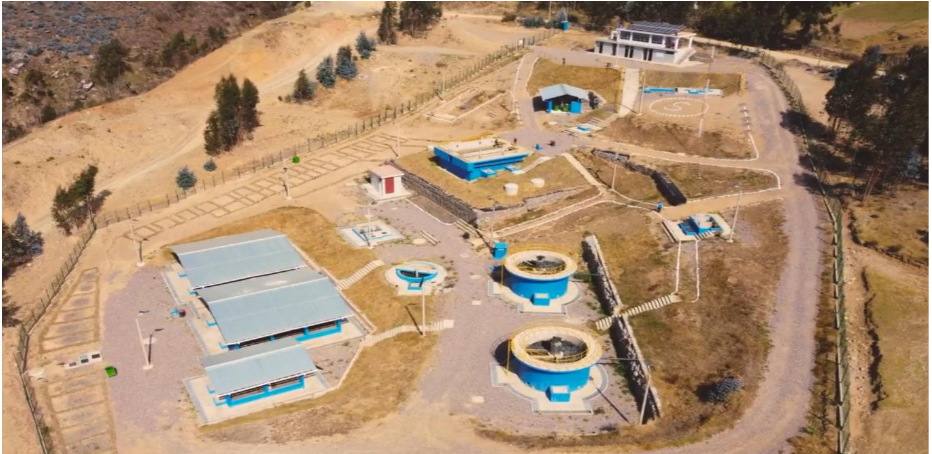
Figura 35. Vista panorámica de la PTAR Colquepata (Filtros Percoladores)
