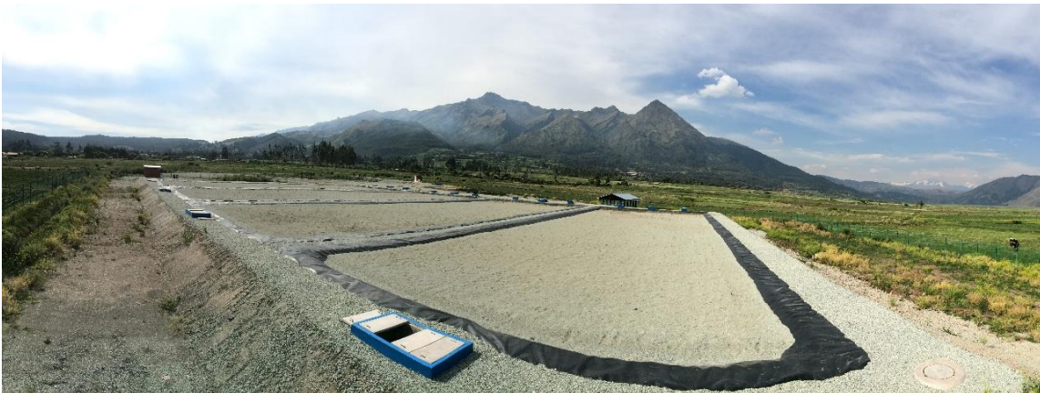
Foto 9. PTAR Zurite, Procedimiento Constructivo (Foto 09 de 14)
