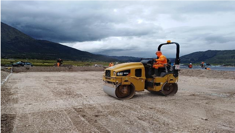
Foto 7. PTAR Zurite, Procedimiento Constructivo (Foto 07 de 14)
