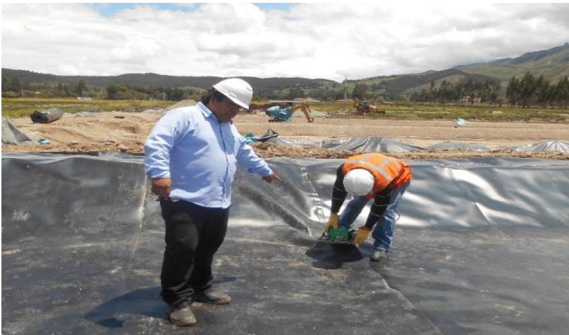
Foto 8. PTAR Zurite, Procedimiento Constructivo (Foto 08 de 14)
