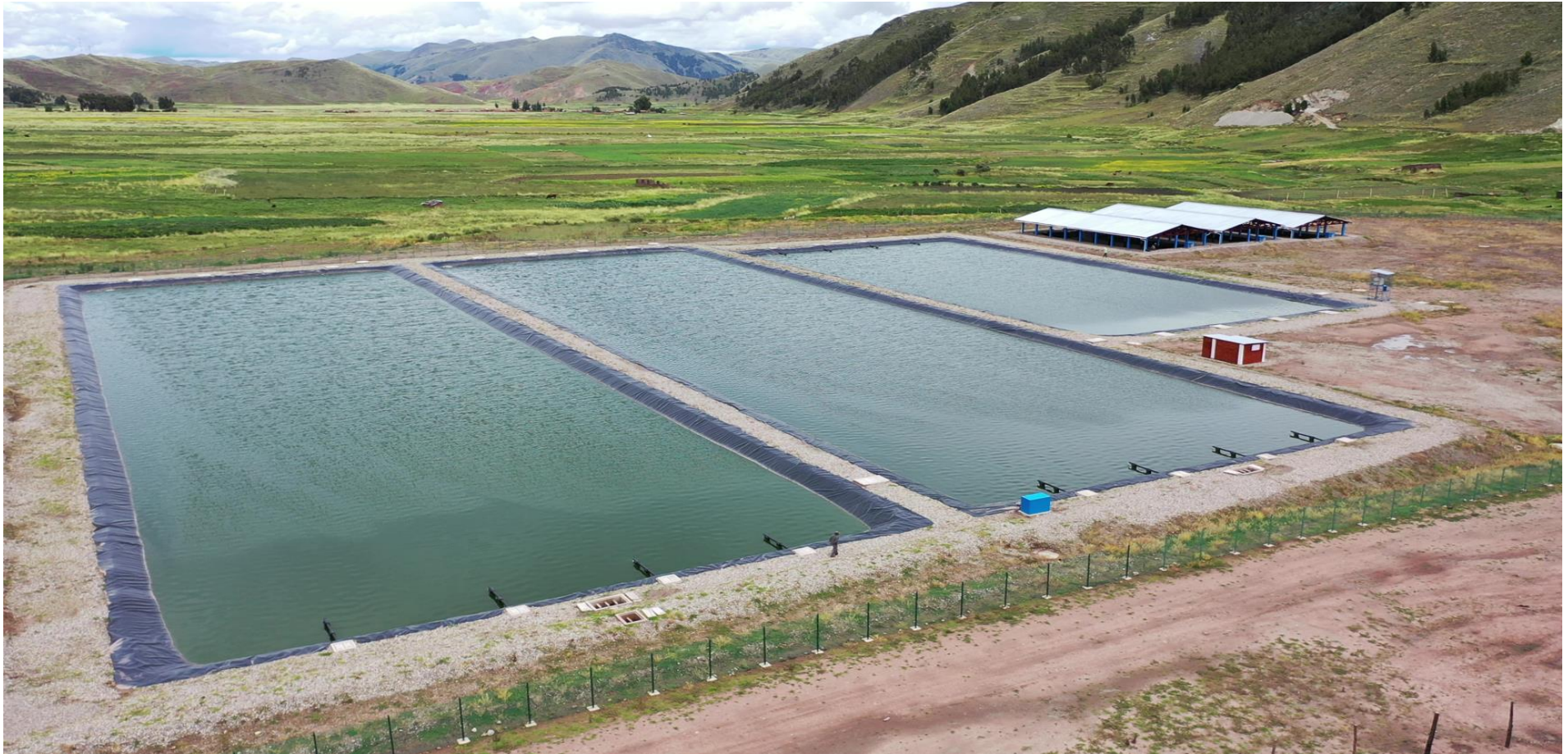
Figura 31. Vista Panorámica de la PTAR Sangarara (Lagunas de estabilización)
