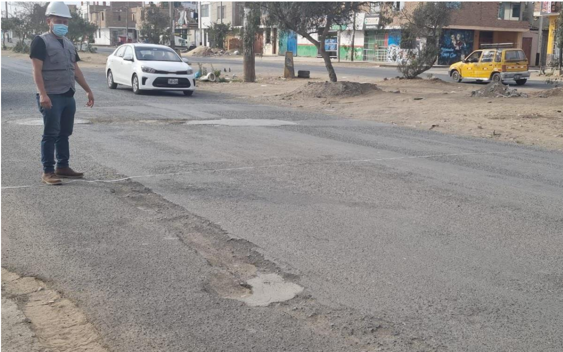
FOTO N°04: REALIZANDO MEDIDAS AL ANCHO DE LA VIA, CUADRA N°12+1.2KM
