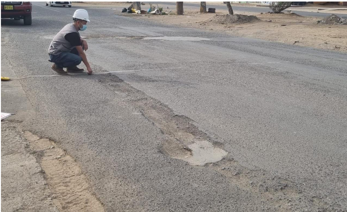
FOTO N°06: REALIZANDO MEDIDAS AL ANCHO DE LA VIA, CUADRA N°05+0.5KM
