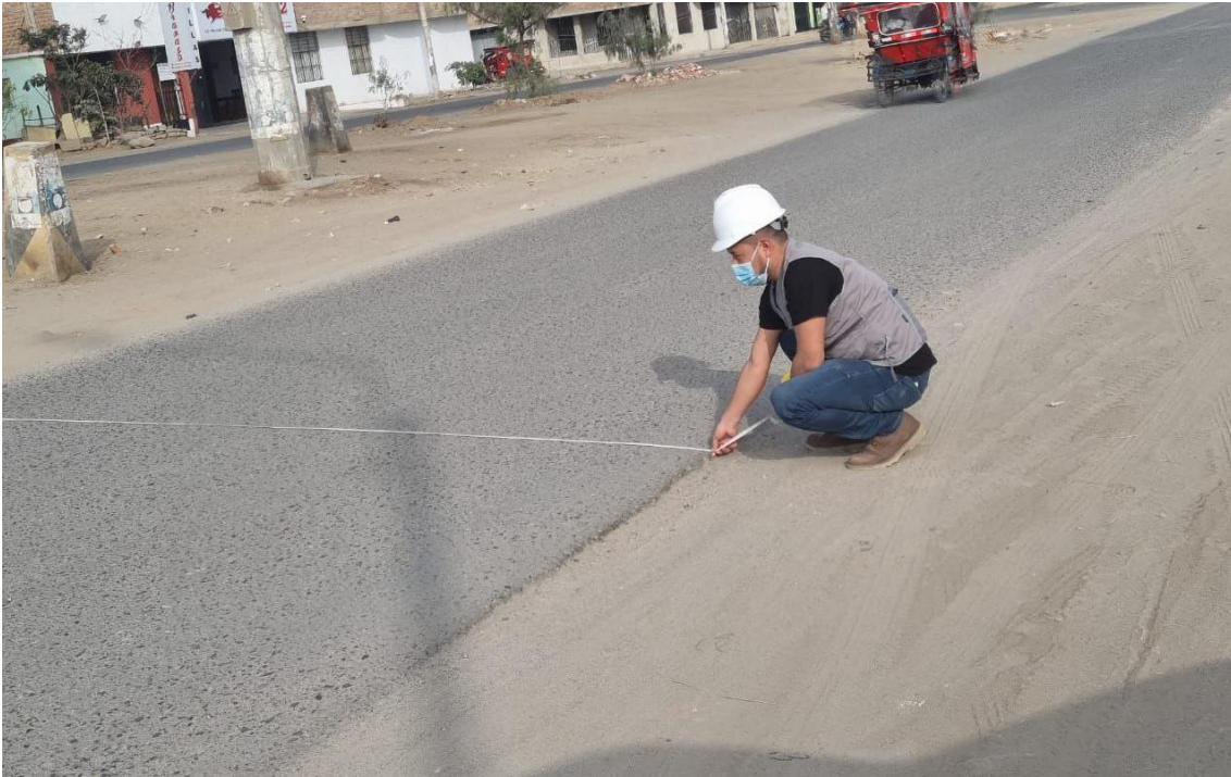
FOTO N°05: REALIZANDO MEDIDAS AL ANCHO DE LA VIA, CUADRA N°08+0.8KM
