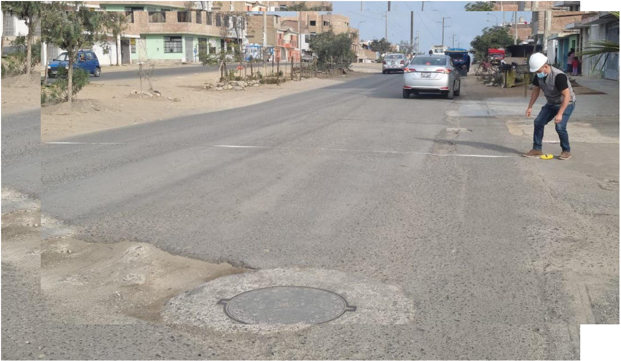
FOTO N°03: REALIZANDO MEDIDAS AL ANCHO DE LA VIA, CUADRA N°12+1.2KM
