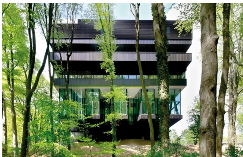
Figura 1: Centro de Rehabilitación Groot Klimmendaal
