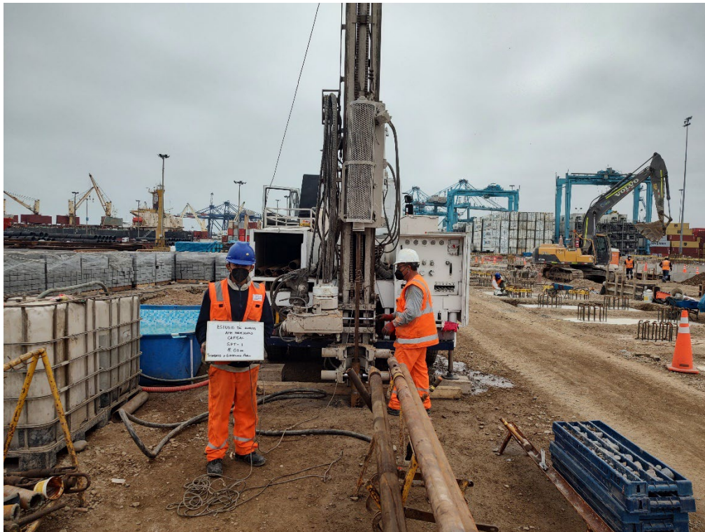
Figura 5. Evaluación de obra en terminal marítimo.
