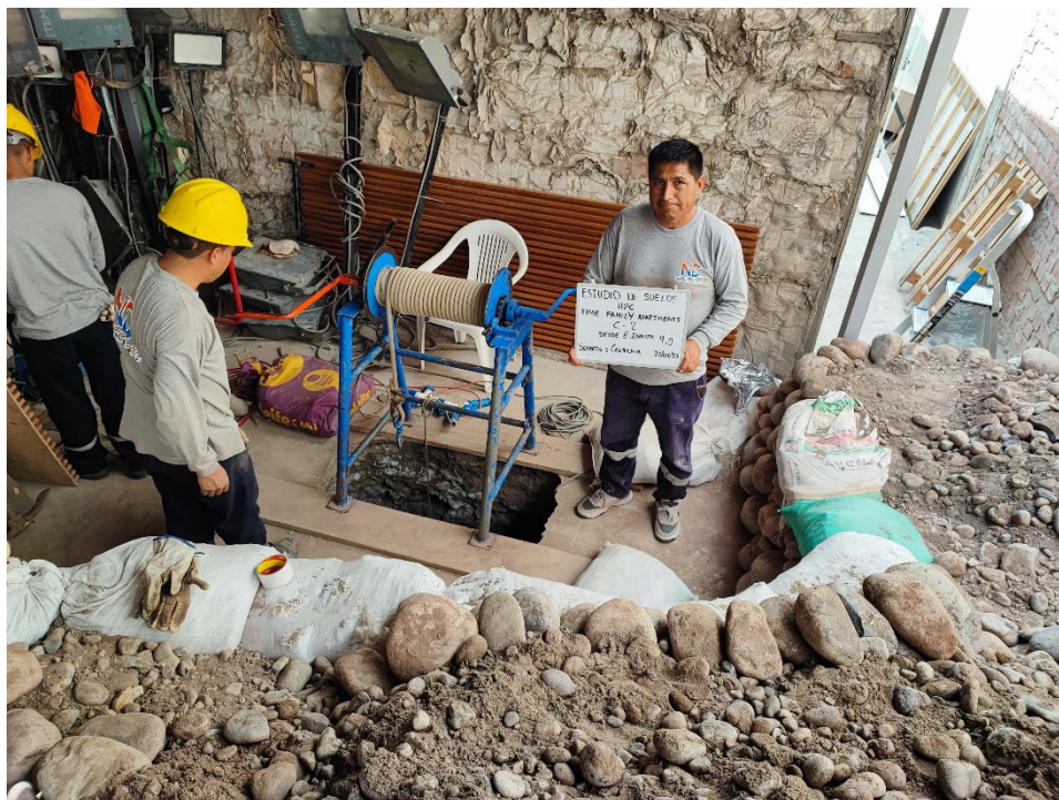
Figura 3. Estudio de suelos reconstrucción en obra de condominios
