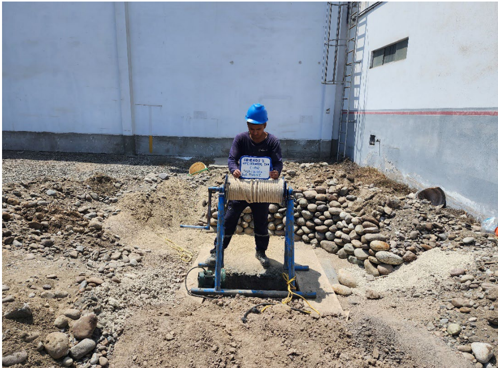
Figura 4. Estudio de suelos reconstrucción en obra de condominios
