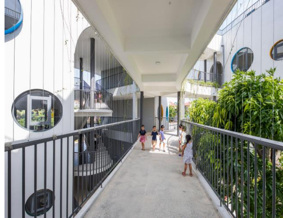
Caso 4 – pasillo exterior- iluminación a través de vanos circulares
