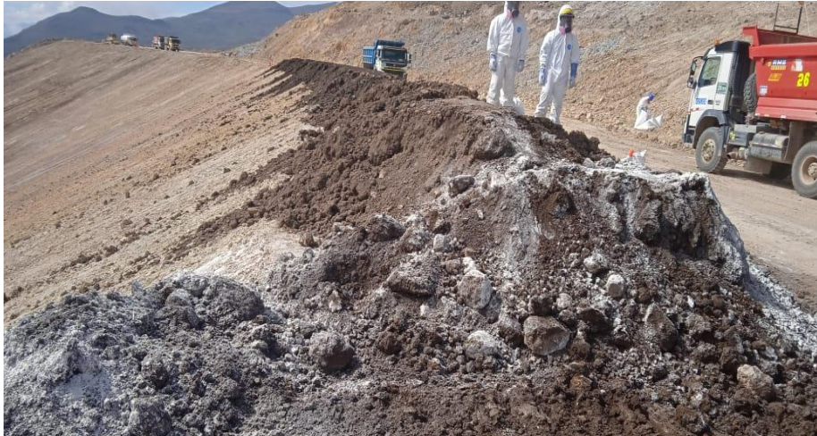
Figura 18. Colocación de \text{Ca}(\text{OH})_2 en el topsoil por pilas
