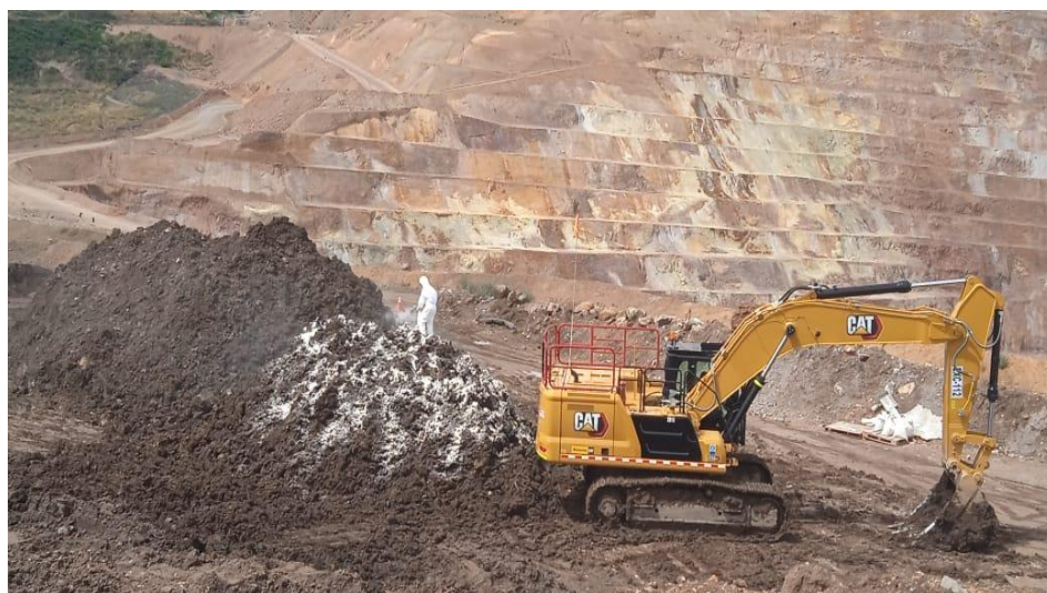
Figura 17. Colocación de \text{Ca}(\text{OH})_2 en el top soil
