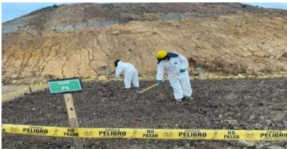
Figura 13. Tapado de semillas con rastrillo
