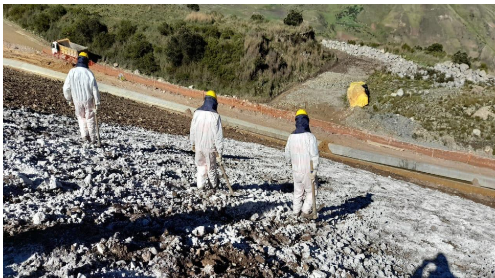
Figura 16. Encalado manual de suelos orgánicos
