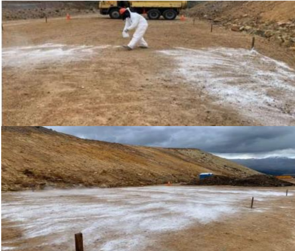
Figura 4. Incorporación de capa alcalina de 0.10 kg por 1m^2
