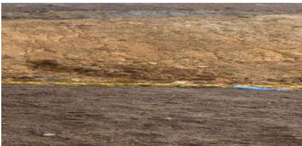
Figura 5. Incorporación y tendido de Top Soil
