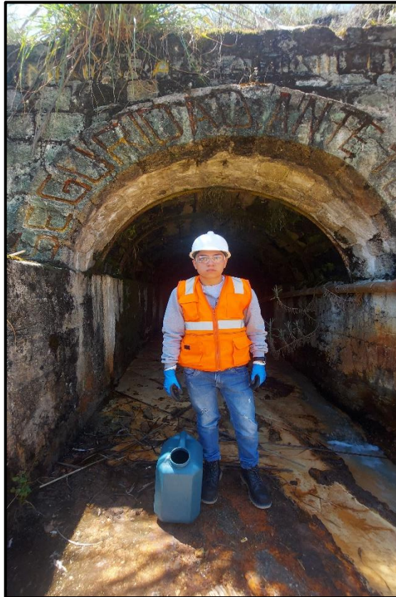
Foto 1. Ingreso a la bocamina de la mina artesanal el Tingo
