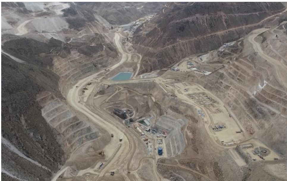
Figura 1. Vista área de proyecto Quellaveco.
