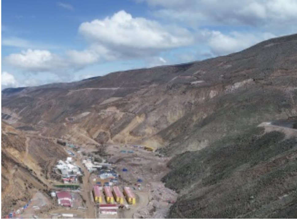
Figura 2. Avance de construcción de proyecto.
