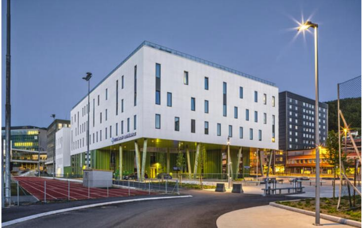
Figura 5: Fachada del Hospital Psiquiátrico Kronstad
