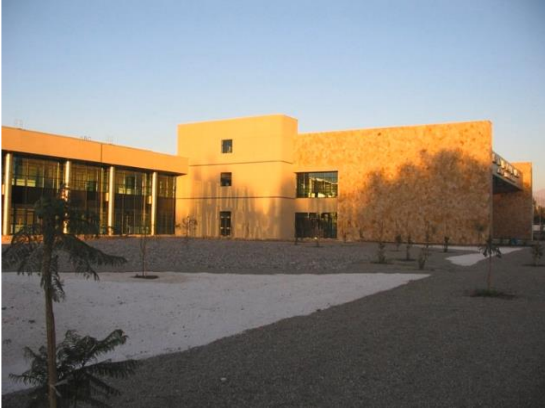
Figura 3: Vista exterior del Hospital provincial del Huasco
