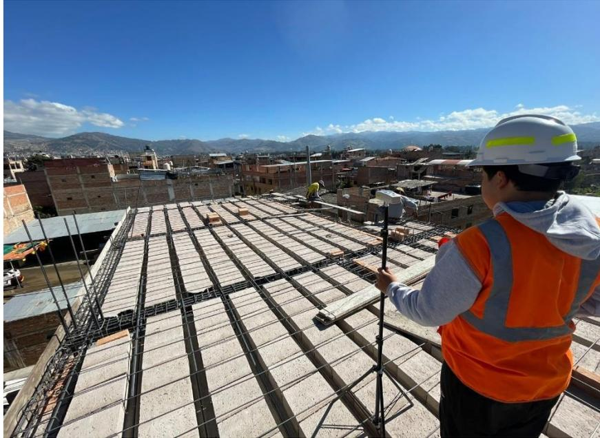
**ANEXO 48.** Vaciado del concreto de la losa en la vivienda N°16
