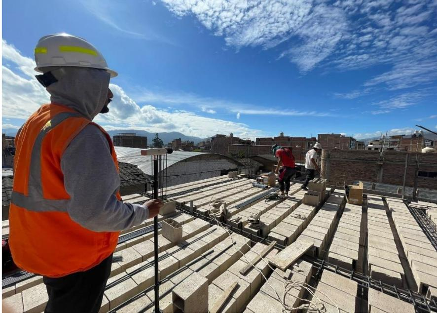
**ANEXO 42.** Vaciado del concreto de la losa en la vivienda N°14
