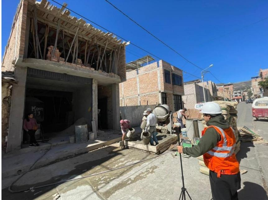
**ANEXO 52.** Encofrado de la losa en la vivienda N°18
