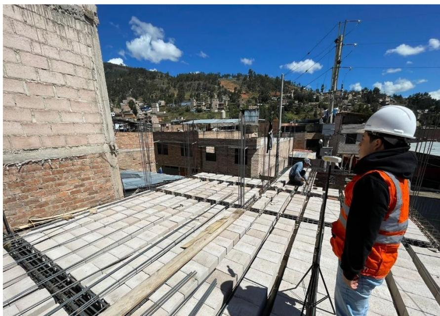
**ANEXO 39.** Vaciado del concreto de la losa en la vivienda N°13
