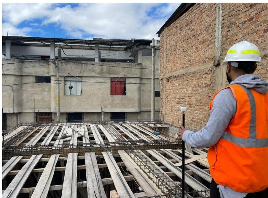
**ANEXO 57.** Vaciado del concreto de la losa en la vivienda N°19
