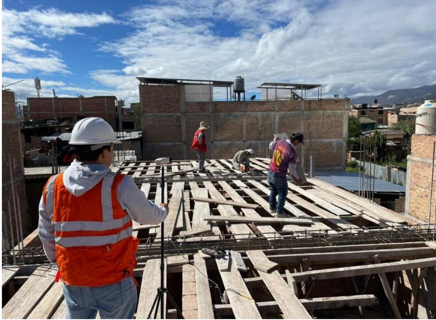
**ANEXO 50.** Colocación del acero en la losa de la vivienda N°17
