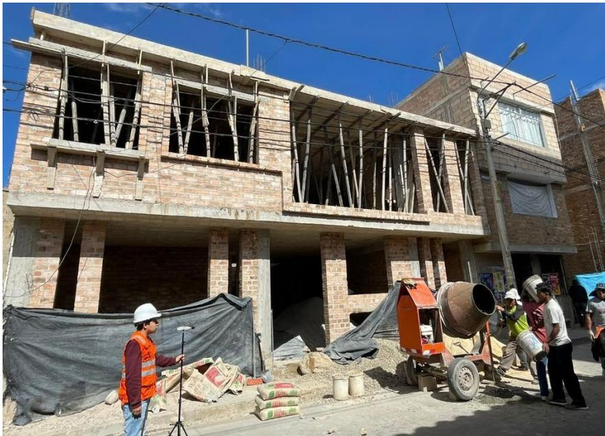
**ANEXO 43.** Encofrado de la losa en la vivienda N°15
