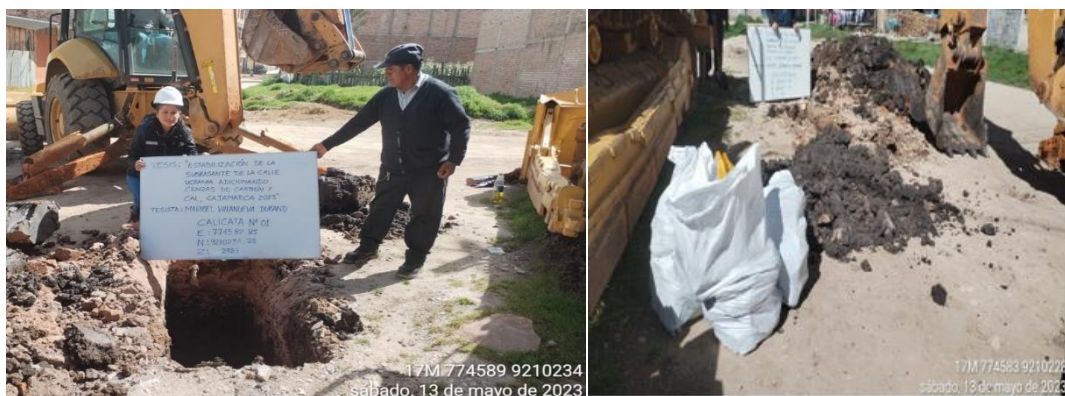
Elaboración de Calicatas y extracción de material.
