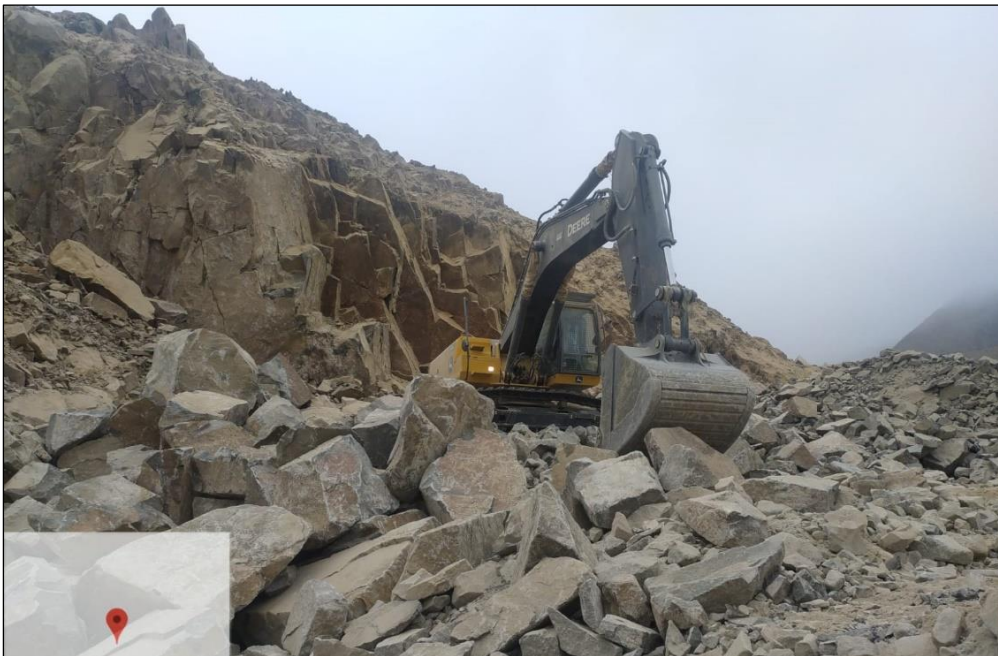
Figura 1. Excavadora realizando trabajos de selección y acopio de roca.
