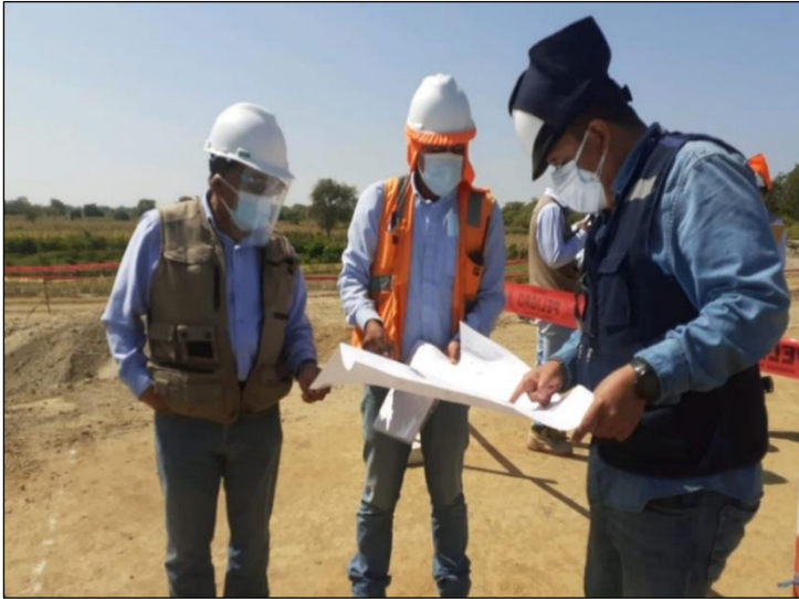
Figura 3. Asesoramiento técnico en obras de ingeniería.
