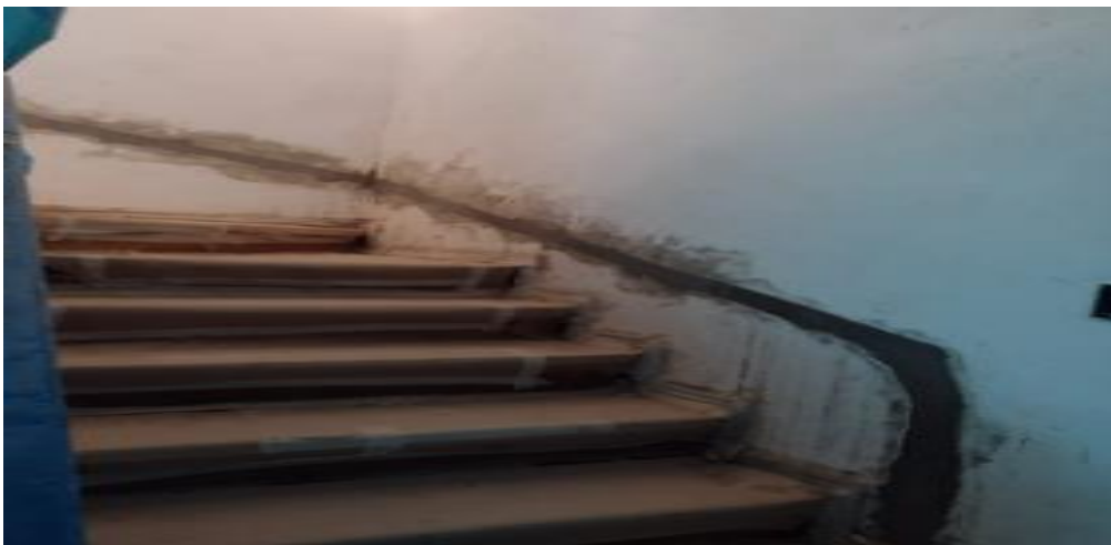
Figura 6. Toma fotográfica de la Instalación de electricidad
