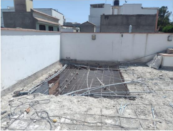
Figura 10. Fotografía de democión de un paño de losa aligerada de terraza
