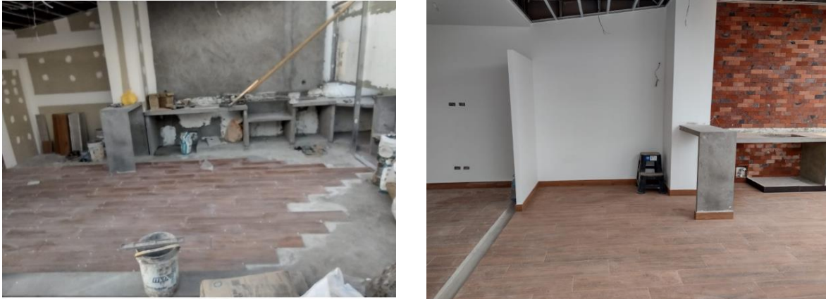
Figura 9. Toma fotográfica del emplantillado y enchapados de cerámicos
