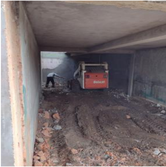
Figura 1. Toma fotográfica de movimiento de tierra
