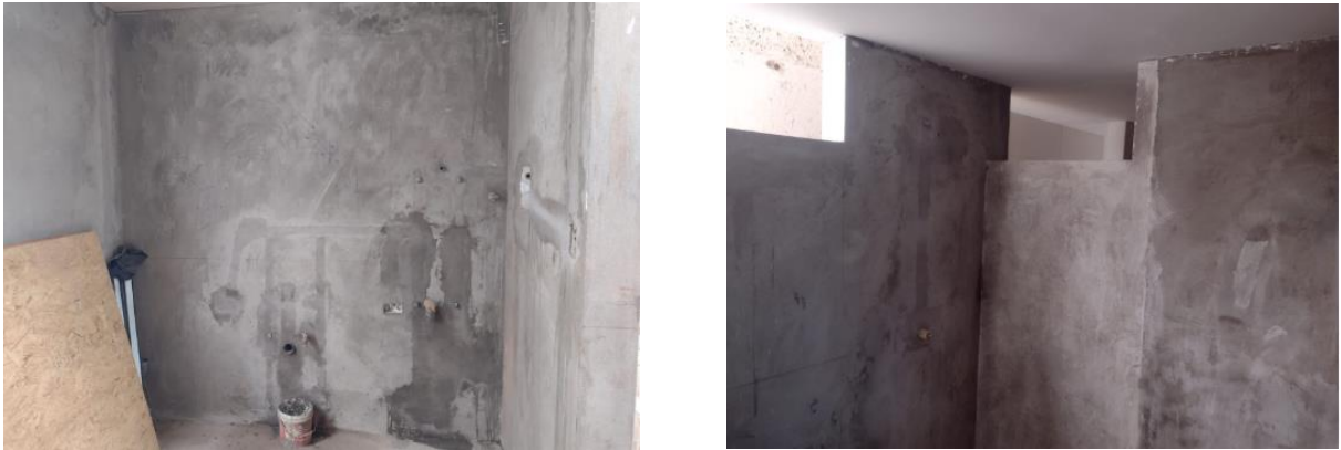
Figura 7. Toma fotográfica del enlucido de muros
