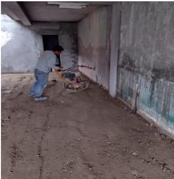
Figura 2. Toma fotográfica de compactación de base granular
