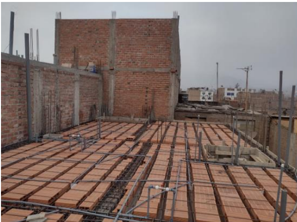
Figura 15. Fotografía de encofrado de techo
