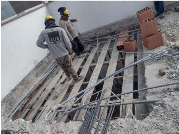
Figura 11. Fotografía de encofrado de losa aligerada
