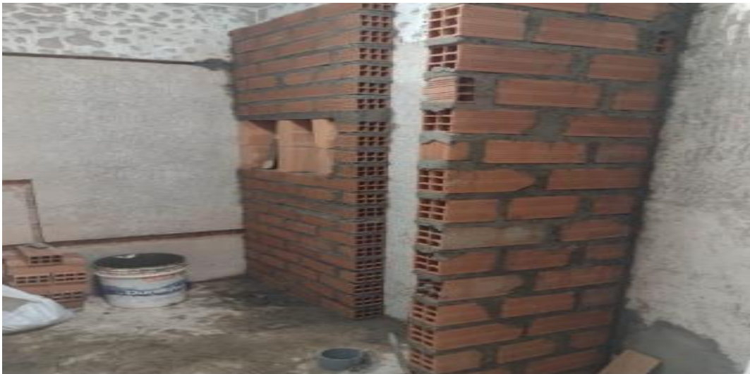
Figura 8. Toma fotográfica de construcción de muros
