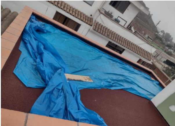
Figura 14. Fotografía de acabado de losa aligerada con manto asfáltico
