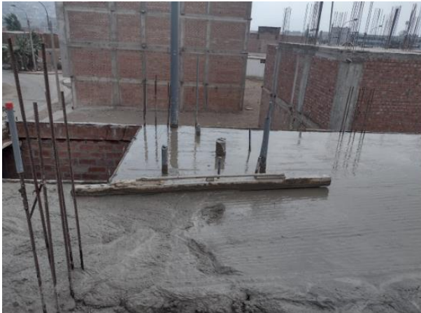
Figura 16. Fotografía de vaciado de techo
