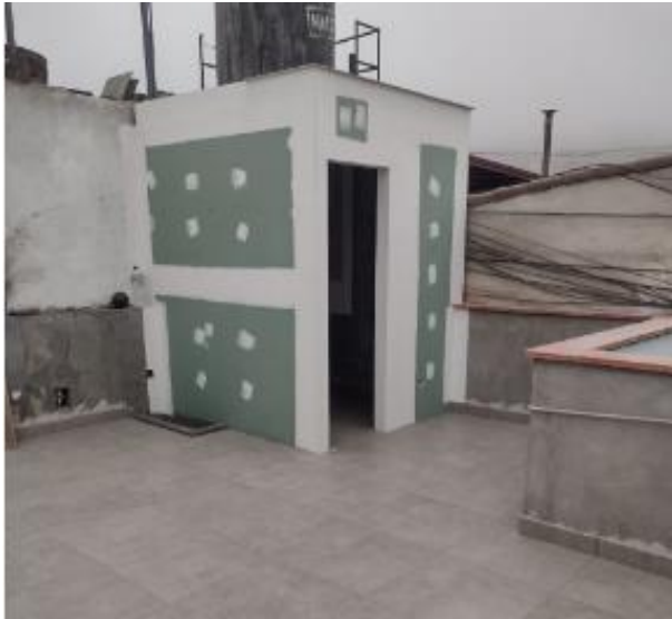
Figura 12. Fotografía de habilitación de almacén con material drywall
