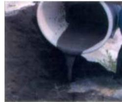
Verter el producto en el interior de los orificios. Esta operación debe realizarse dentro de los 15 min siguientes al mezclado.
