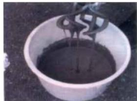
Mezclar **BUSTER** con agua limpia y con un agitador hasta lograr completa homogeneidad. La masa debe ser uniforme y sin grumos.
