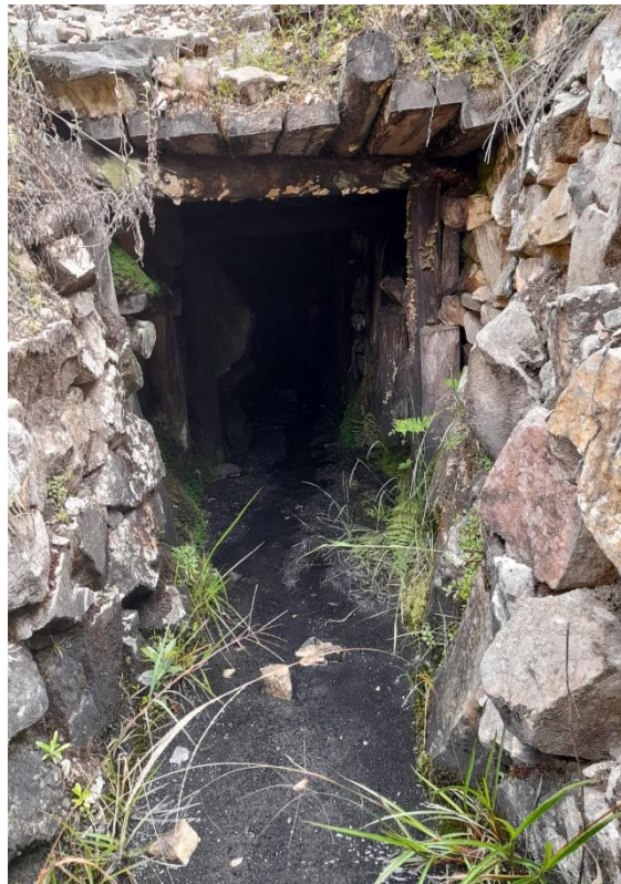
Foto N°2: Bocamina N°2, no presenta drenaje
