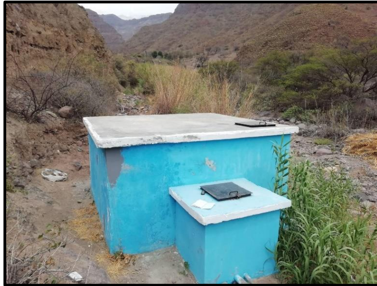
Figura 8 Reservorio 1 capacidad 20 m 3
