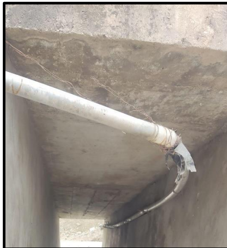
Figura 6 Pase aéreo en alcantarilla
