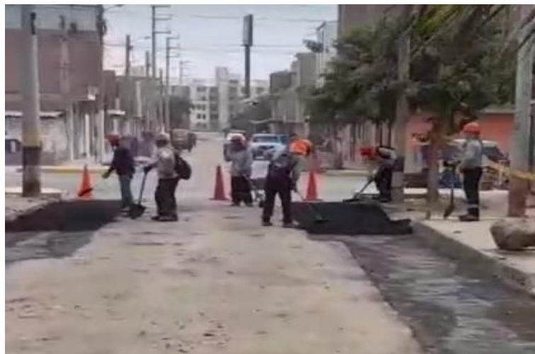
Ilustración 13 Cuadrilla de obreros.
