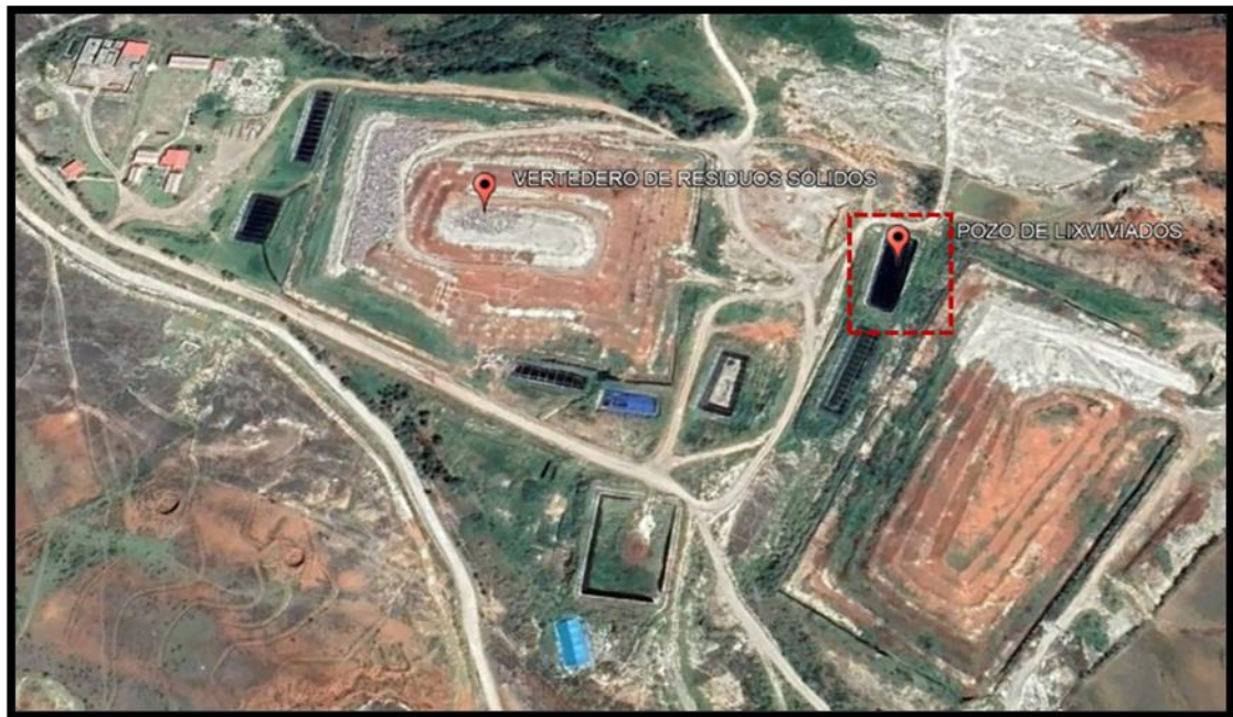
Figura 2 Ubicación del pozo de lixiviados
