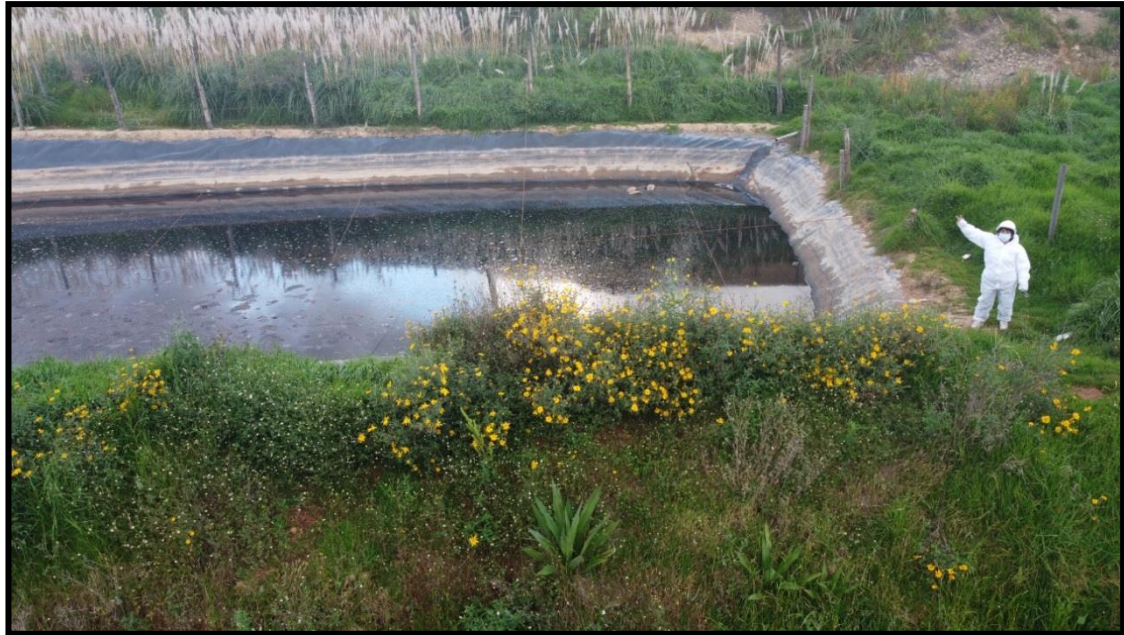
Figura 3. Ubicación del pozo de lixiviados
