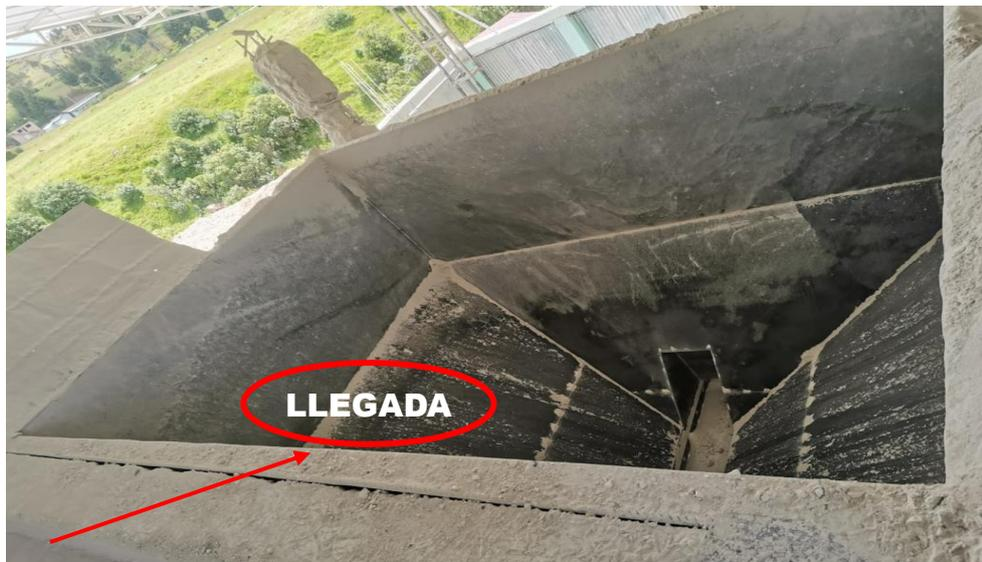
*Figura N° 29: Punto de llegada de faja transportadora a boca de silo.*
