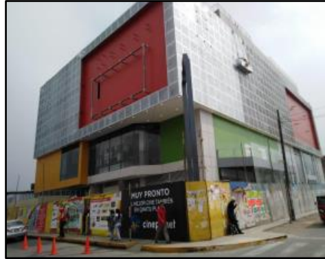
Figura 6: Construcción de Estructuras en CINEPLANET
