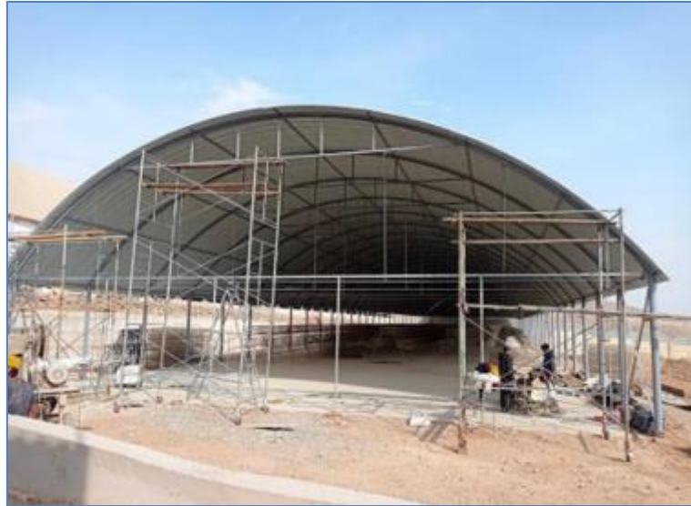
Figura 25: Local en construcción de Vifamap SAC, año 2014
