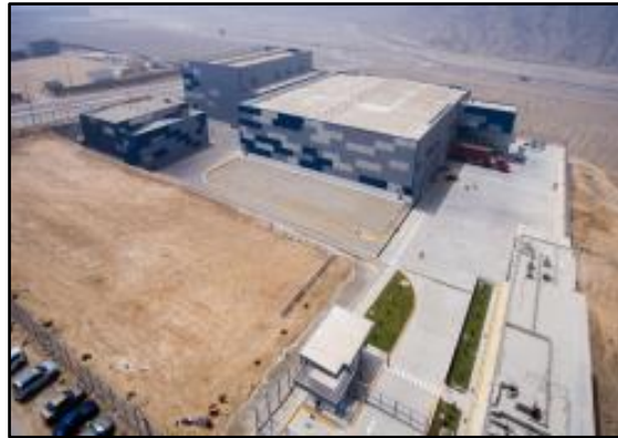
Figura 9: Construcción de Planta Industrial VIRUTEX ILKO
