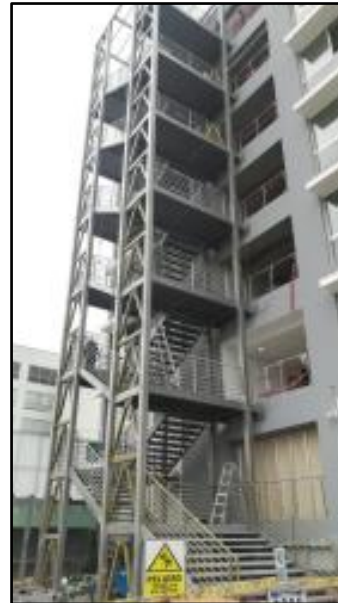
Figura 7: Construcción de Estructuras Metálicas y acabados
