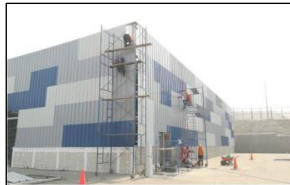
Figura 5: Construcción Ampliación de Almacén Scrap 1000m2
