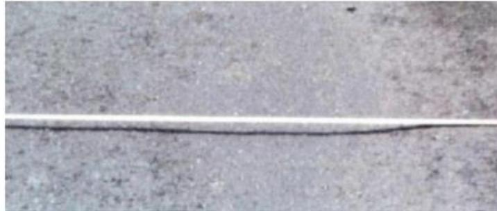
**Figura 4: Abultamientos y hundimientos**
