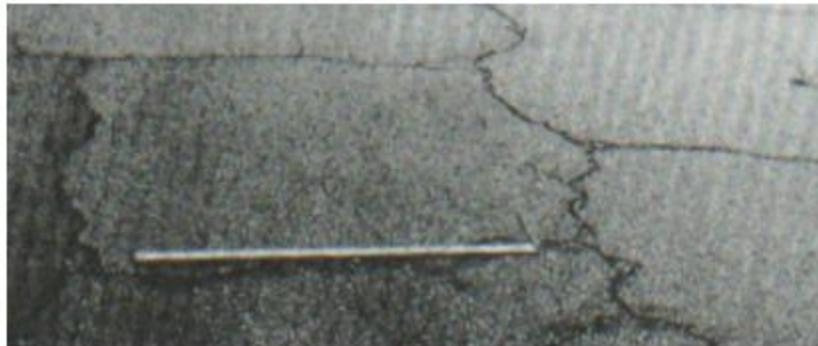
**Figura 6: Agrietamiento en bloque**
