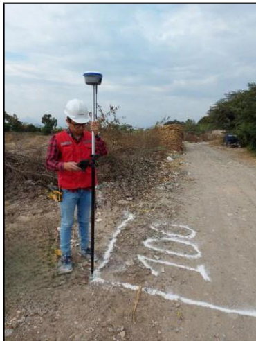
Fig. 4 Toma de coordenadas con equipo GNSS.
