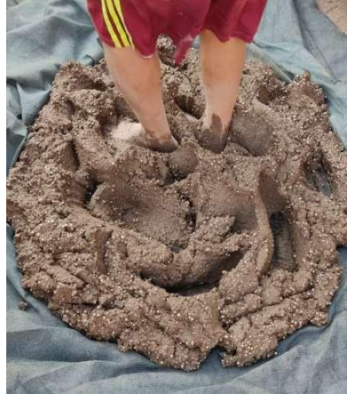
Mezclado de agregados
