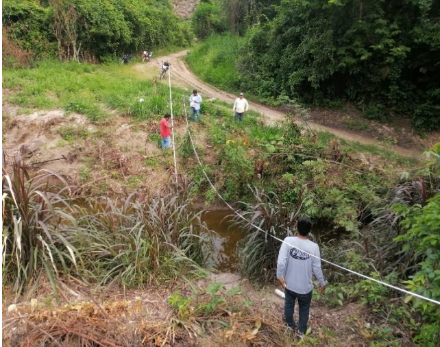
Se observa el levantamiento topográfico el trazo
