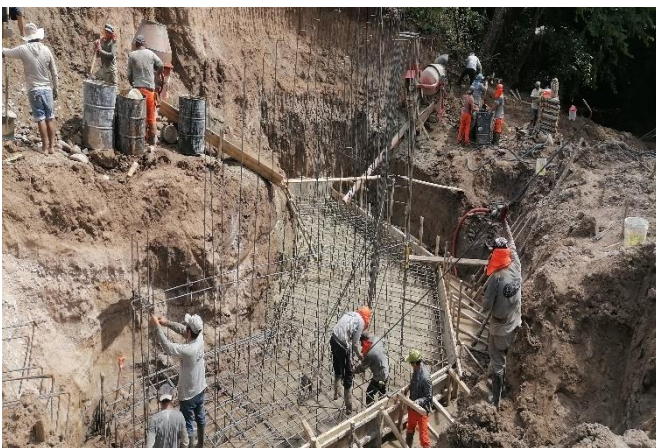
Se observa la colocación del acero de refuerzo f_y=4200\text{kg/cm}^2 para e escribo del puente
