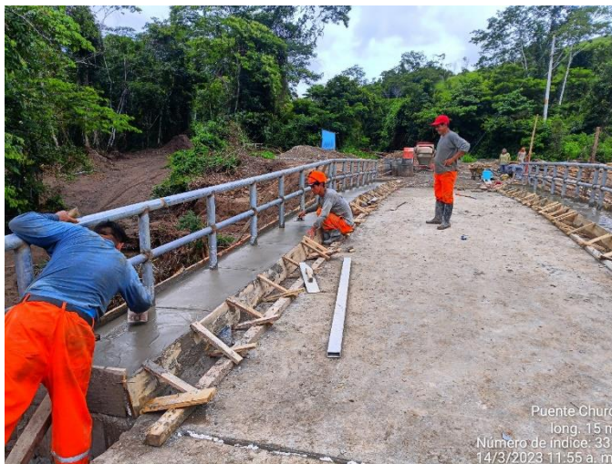
Se observa el bruñado en las veredas
