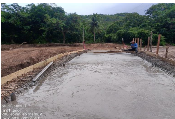
Se observa el vaciado de la losa de f'c=280\text{kg/m}^2
