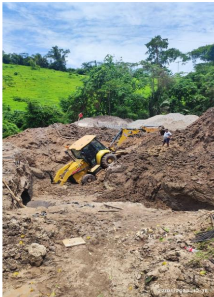
Se procedió a realizar la excavación con máquina para la zanja para la formación de los estribos
