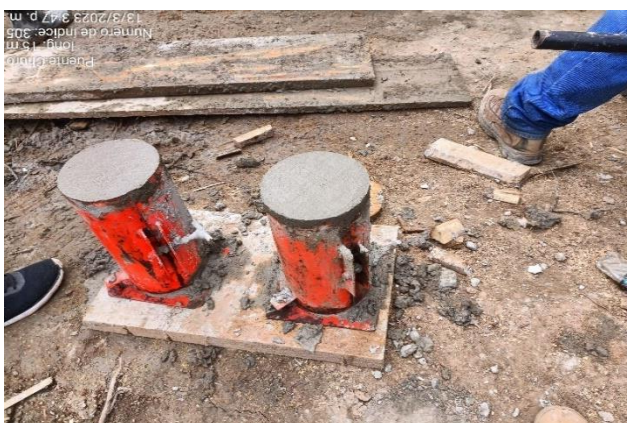
Se observa las probetas que se realizó para la losa para control de calidad
