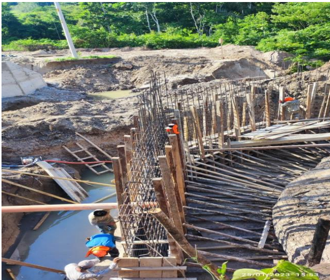
Se procedió a ejecutar el encofrado de los muros aleros
