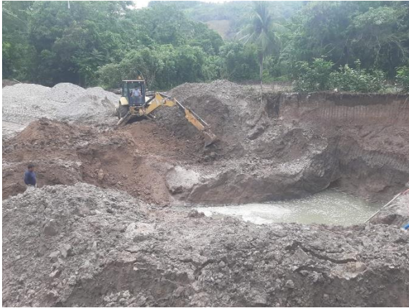
Se observa la excavación suelo gravoso bajo el agua.
