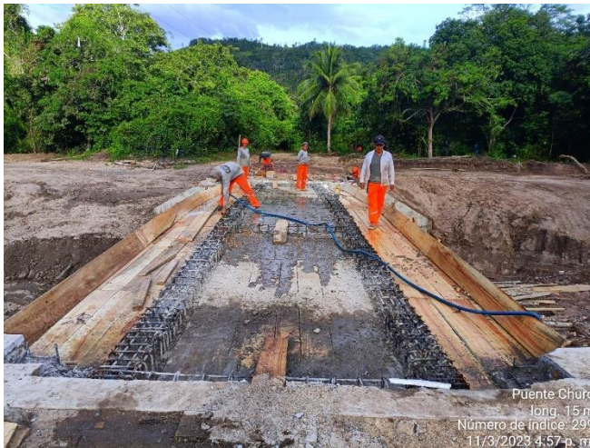
Se observa el encofrado para la vereda
