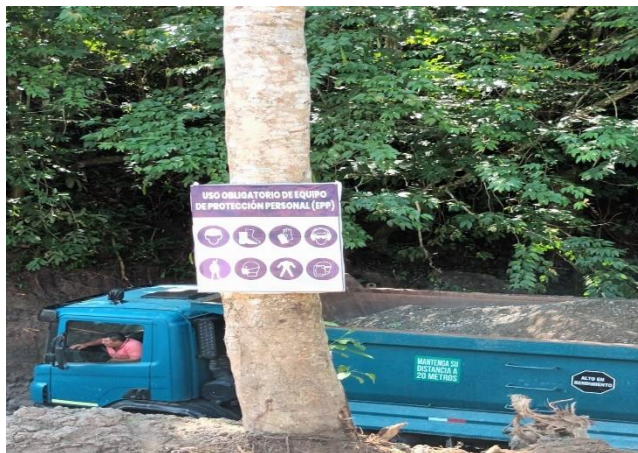
Se coloco carteles provisionales de seguridad en el área de trabajo
