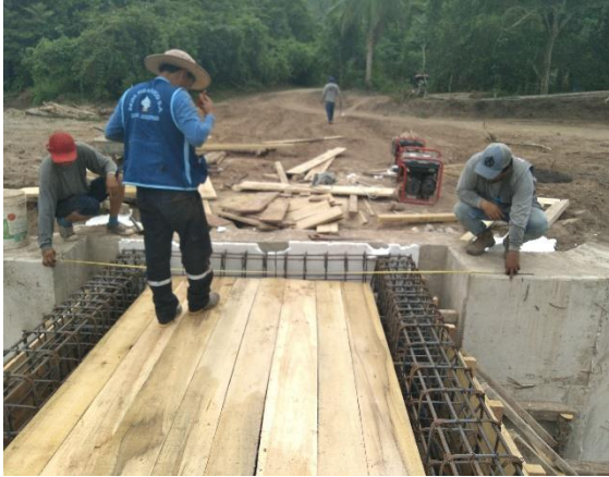
Se observa la medición del puente y también la colocación de la junta de teknoport
