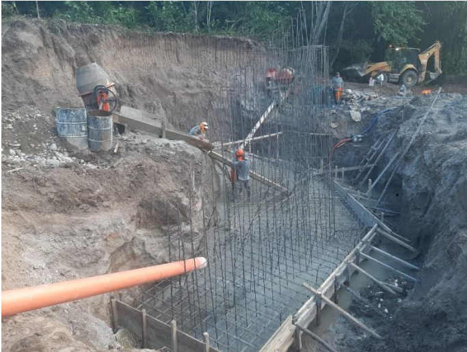
Se observa el vaciado de concreto de f'c=210\text{kg/m}^2 para la zapata.
