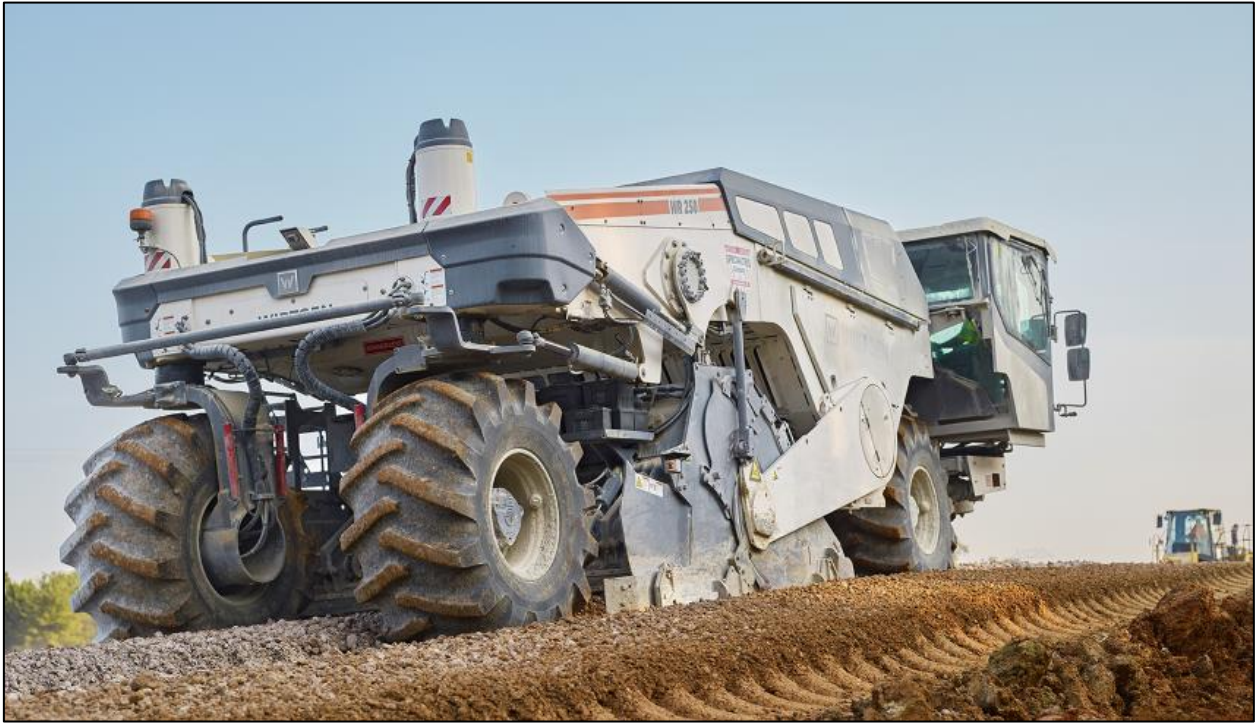
Figura 2: Estabilización de suelos
