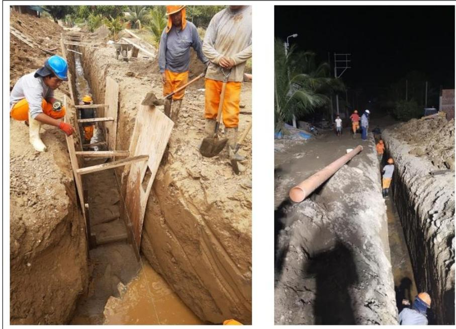
Imagen 42. Proceso constructivo, entibado y tendido de redes.
