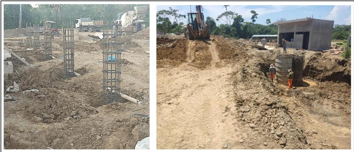
Imagen 58. Columnas para coberturas metálica y caseta de guardianía
