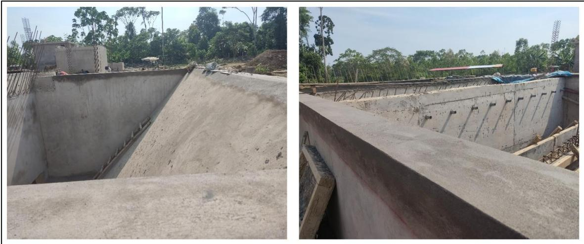
Imagen 51. Proceso constructivo del tanque Imhof.
