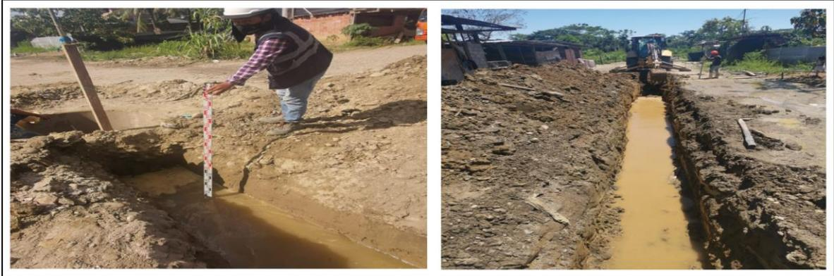
Imagen 60. Trabajos en terreno saturado
