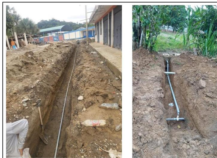
Imagen 38. tendido de redes de agua potable
