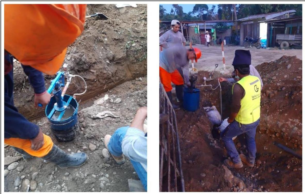
Imagen 39. Pruebas de presión para la tubería de agua potable.
