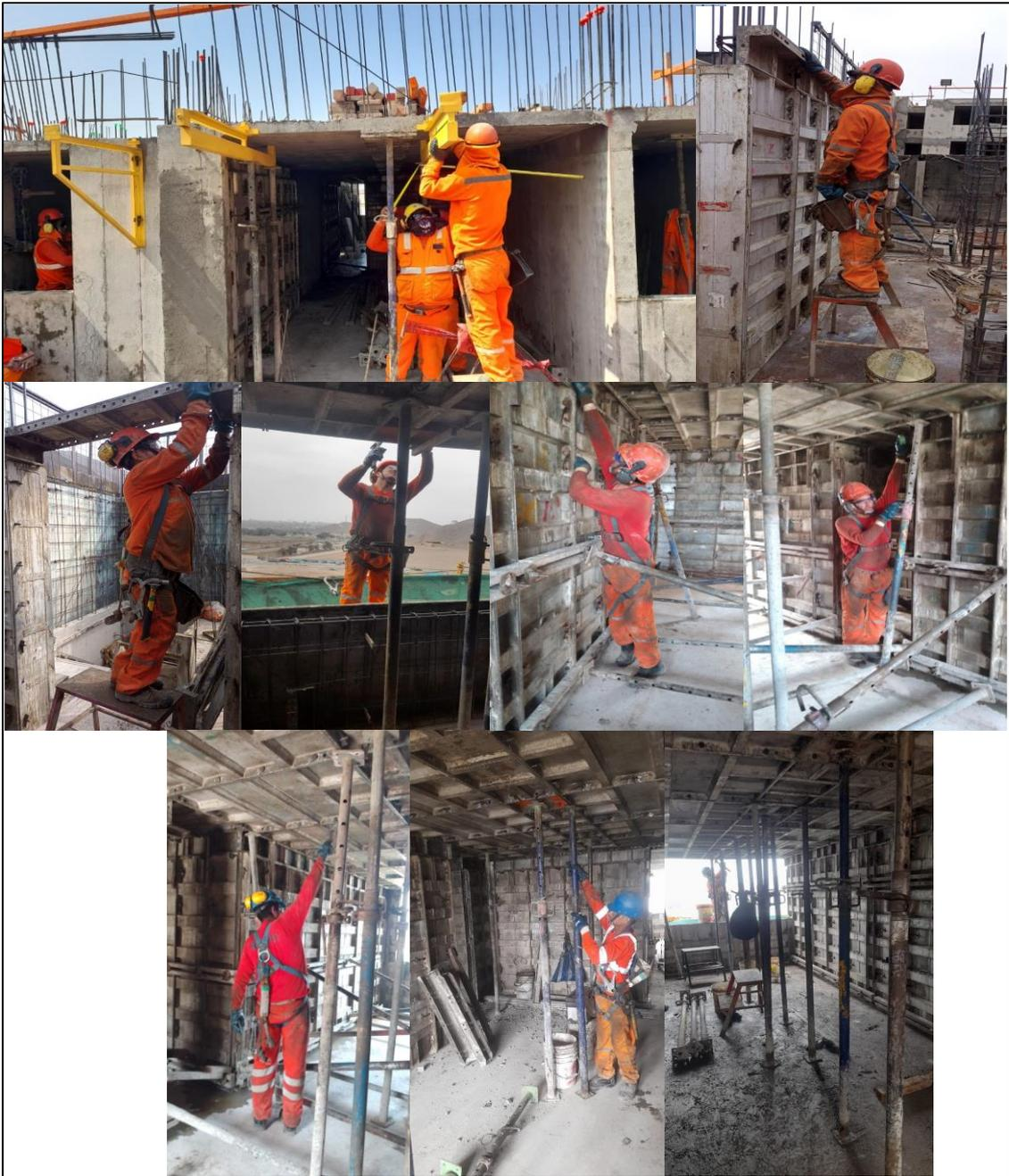
*Nota.* Panel fotográfico del encofrado modular que muestra el nivel de seguridad en el encofrado. Fuente: tomado del proyecto Altos V, Las Lomas del Rímac (INMOBILIRIA BESCO).
