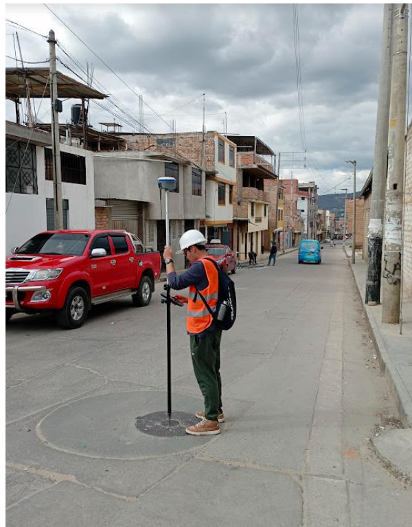
Levantamiento de Tapa de Buzón – Barrio Mollepampa
