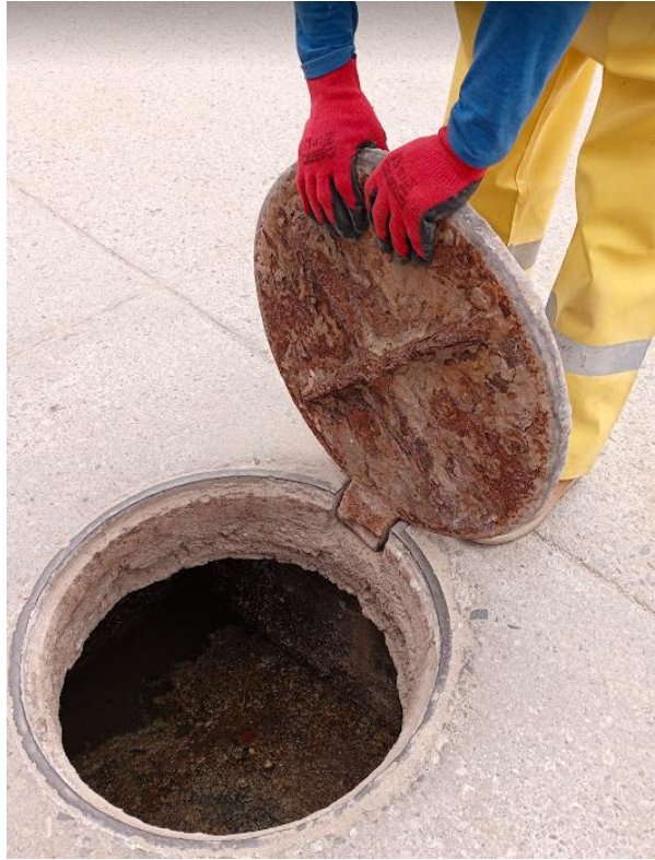
Apertura de Buzón Final en Barrio Campo Real
