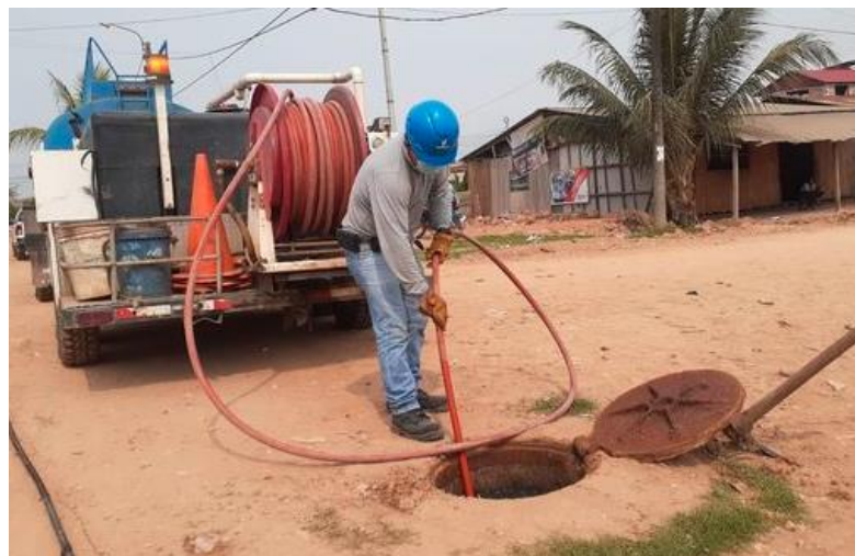
Figura 5 Buzón de Inspección
