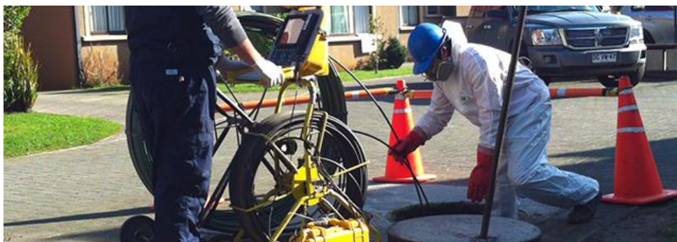
Figura 7 Mantenimiento Preventivo y Correctivo
