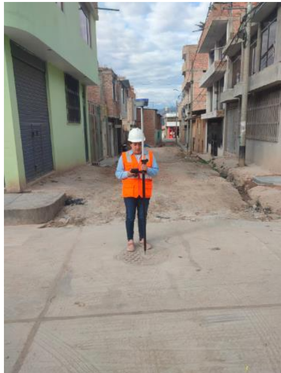
Levantamiento de Tapa de Buzón – Barrio Mollepampa
