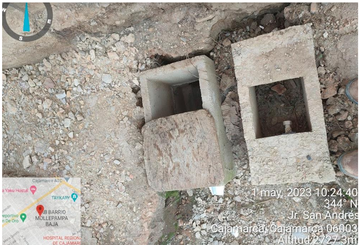
Caja de Registro Jr. San Andrés – Barrio Mollepampa
