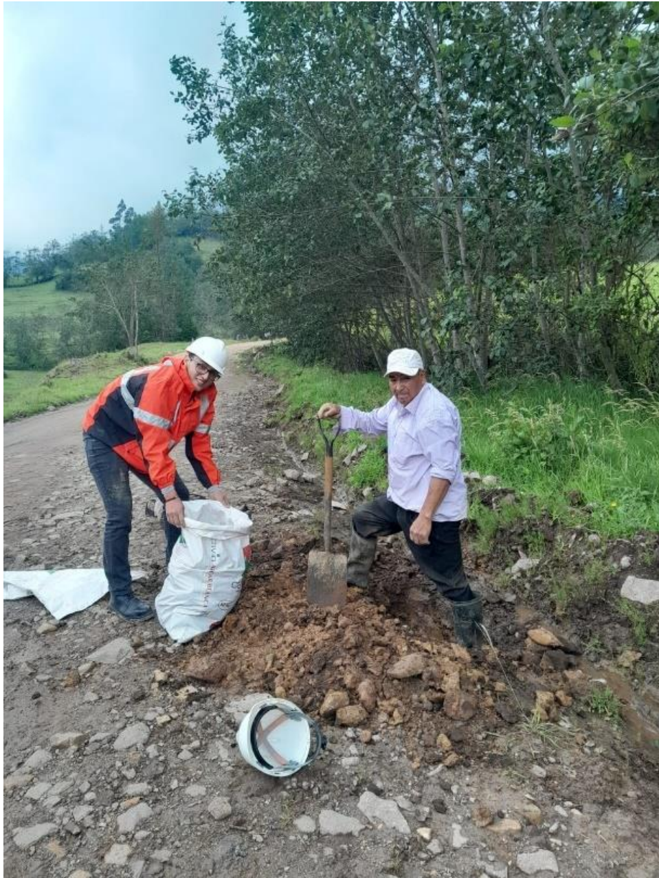
Nota: Excavación y extracción de muestra de la calicata 3 – km 05+160.
