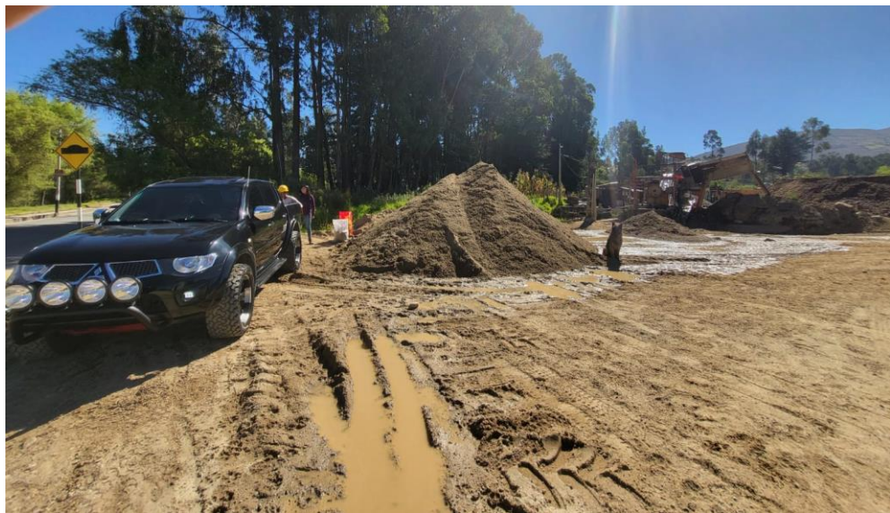
Vista de Cantera agregados
