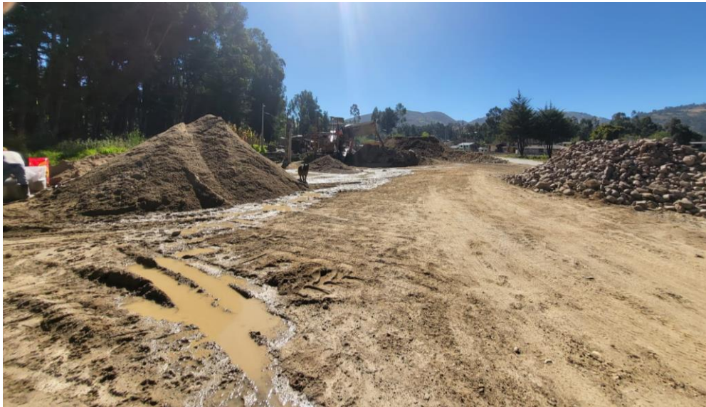
Vista de Cantera agregados
