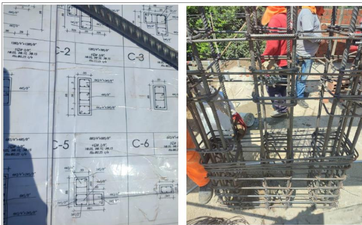
Figura 14: Habilitado de estructura de columna C-2
