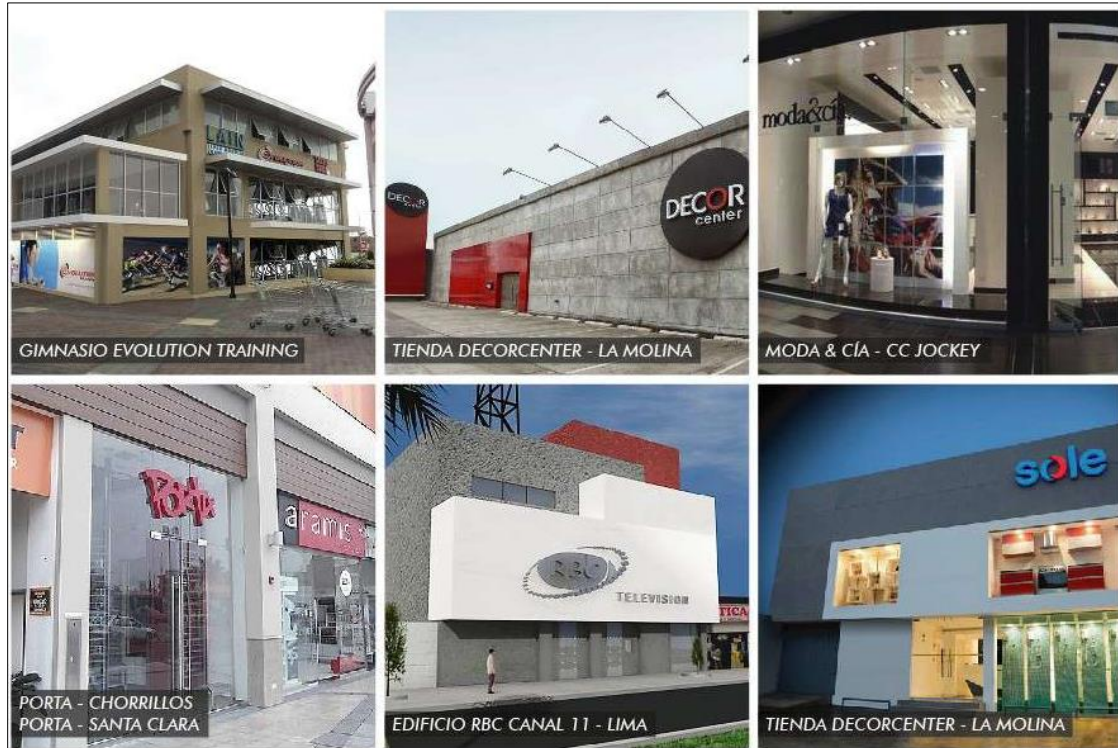
Figura 2: Trabajos de remodelación y mantenimiento en el sector Retail.
