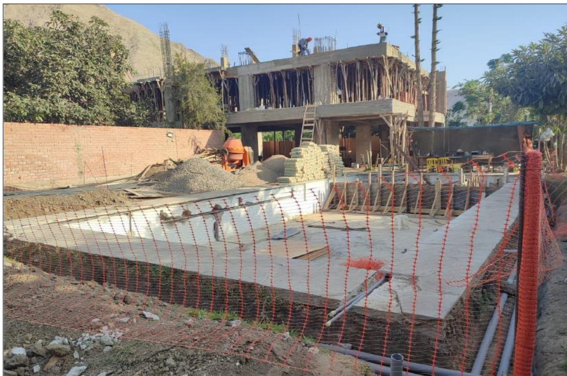
Figura 15: Protecciones colectivas instaladas en obra.
