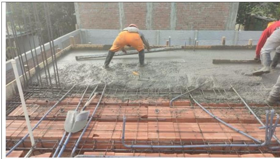
Figura 13: Vaciado de concreto premezclado en losa aligerada.
