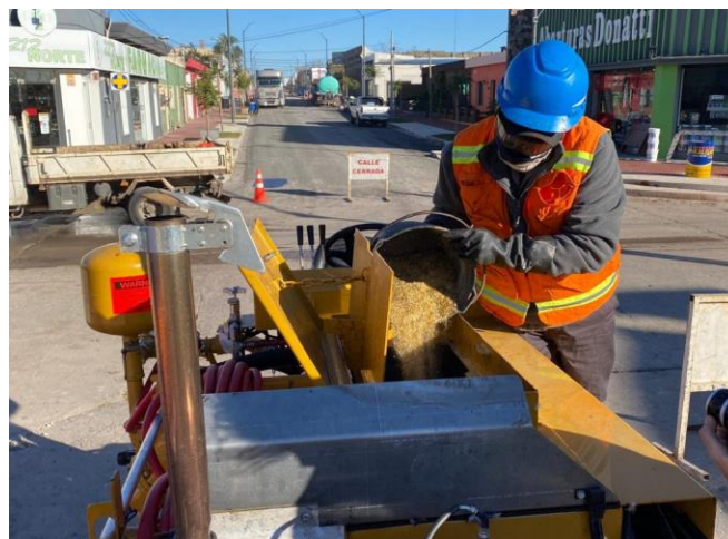
Figura 2 . Vaciado del polvo de vidrio reciclado (Grupo Bitafal, 2021)
