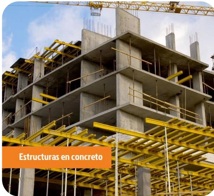
**Dual:** Una estructura dual está compuesta por; vigas, columnas, muros estructurales y/o muros portantes de albañilería. Los elementos de muros de albañilería o concreto, las vigas y columnas soportan las cargas verticales y laterales para transmitirlo a la cimentación.
