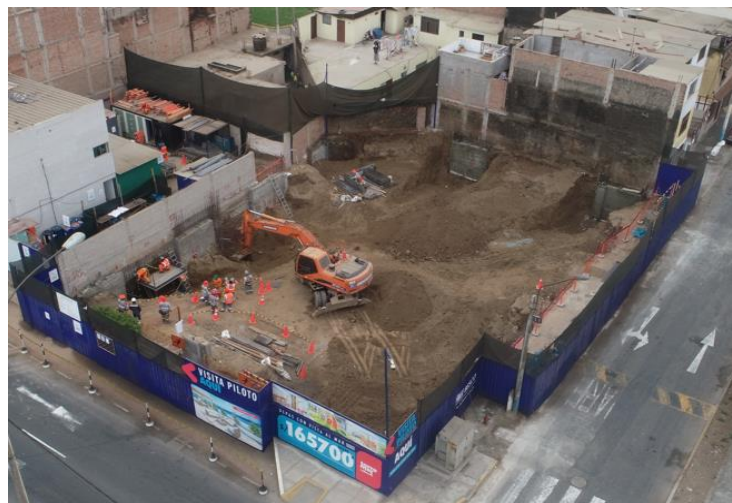
Figura 45 Excavación localizada – Sector 1 Nivel 1
