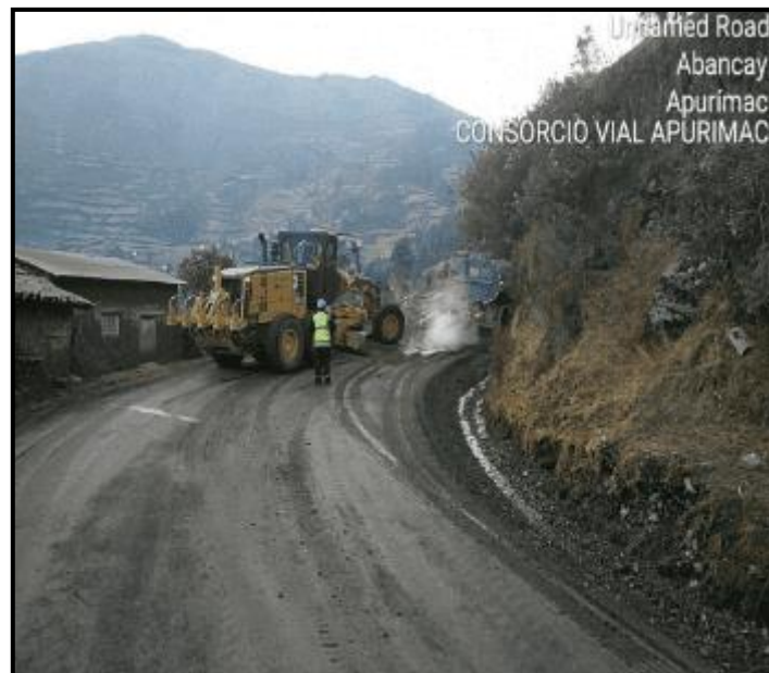
Figura 40: Compactado de base estabilizada con emulsión asfáltica.
