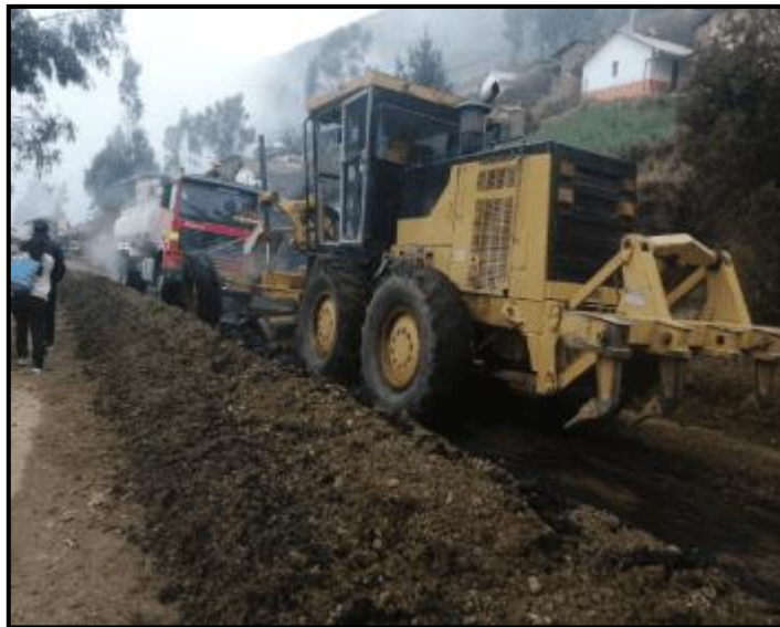
Figura 39: Batido de base estabilizada.
