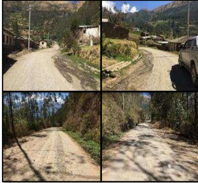
Figura 64: Etapa pre PROG. 11+00 a 13+00.
