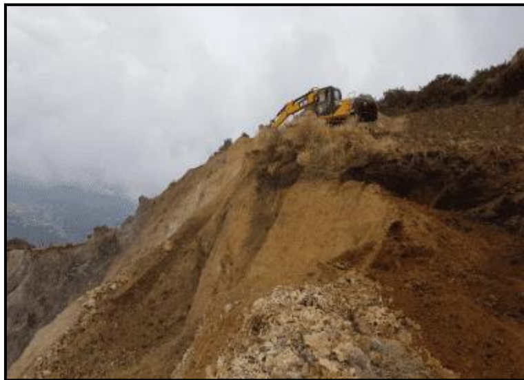
Figura 28: Limpieza de material orgánico de cantera.
