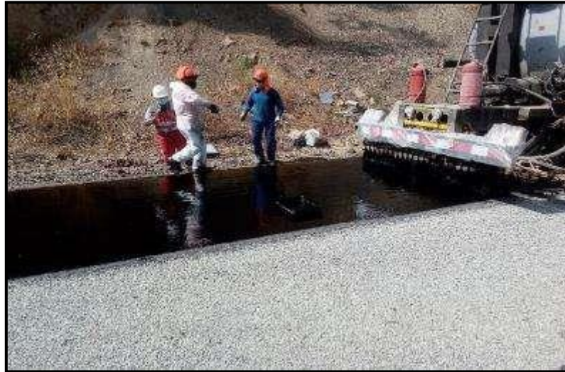
Figura 41: Riego de primera capa de emulsión asfáltica
