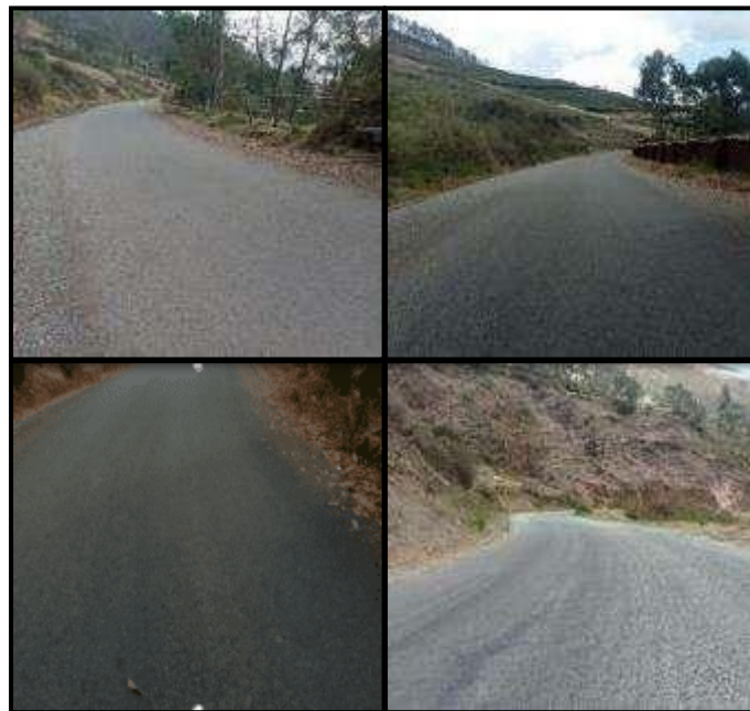
Figura 61: Etapa post PROG. 07+00 A 10+00.
