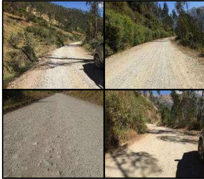
Figura 60: Etapa pre PROG. 07+00 a 10+00.
