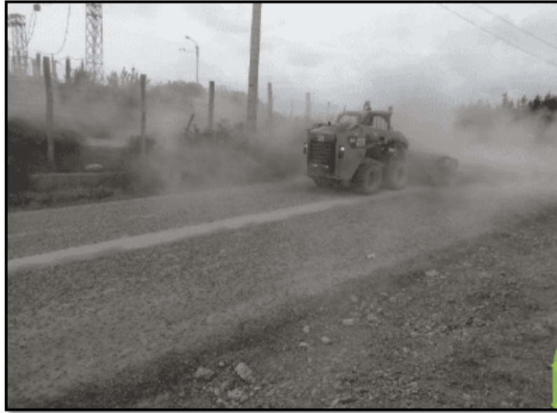
Figura 46: Limpieza de superficie de primera capa de T.S.B.
