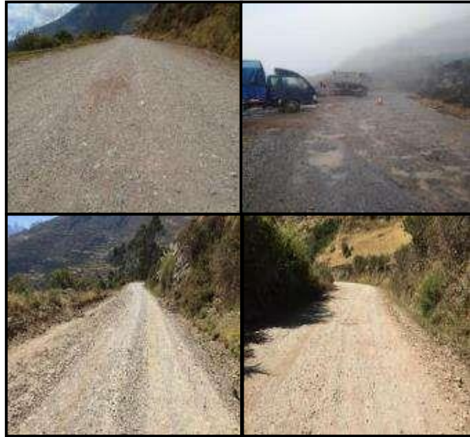
Figura 56: Etapa pre PROG. 03+00 a 06+00.
