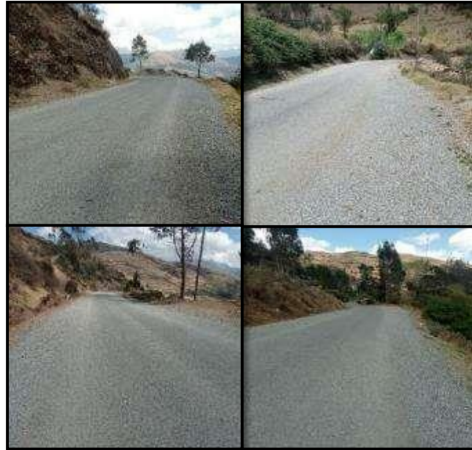
Figura 53: Etapa post PROG. 01+00 a 02+00.
