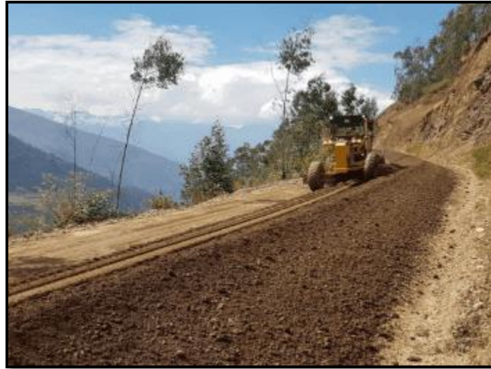
Figura 33: Esparcido de material de cantera.
