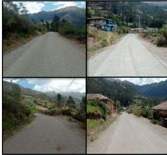
Figura 63: Etapa post PROG. 10+00 a 11+00.
