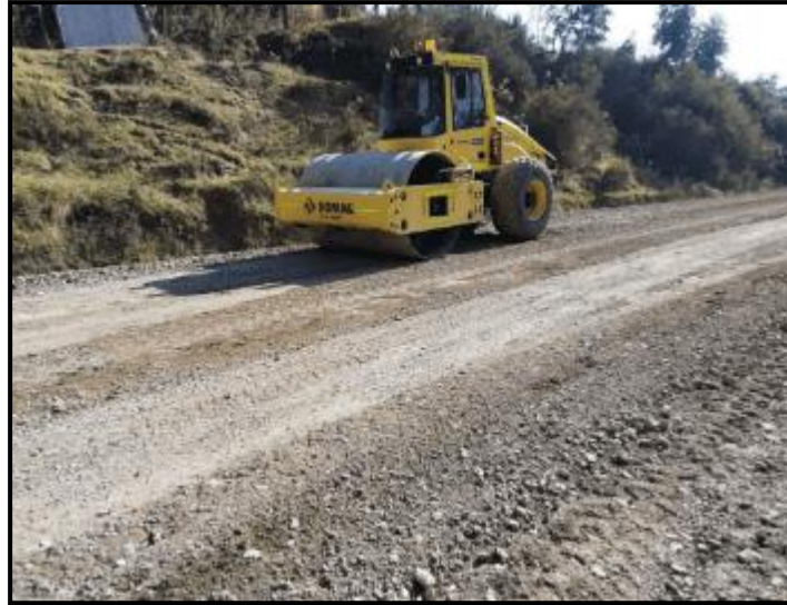
Figura 34: Compactación de material de cantera.
