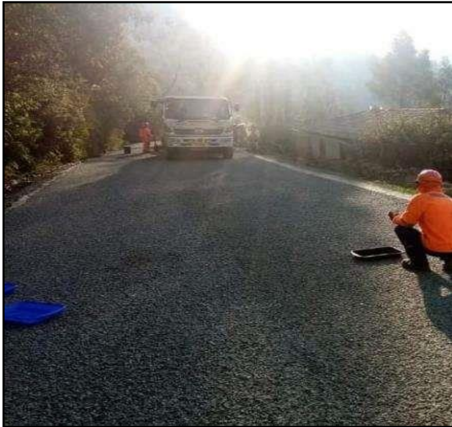
Figura 49: Foto general tratamiento superficial bicapa.
