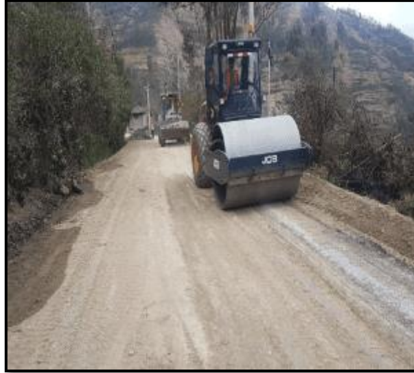
Figura 1: Capa compactada de material granular.
