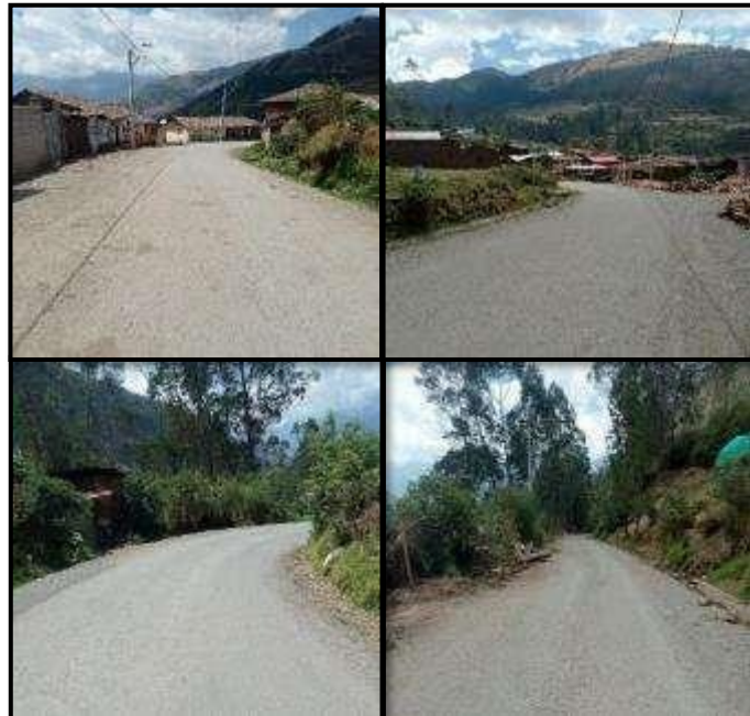
Figura 65: Etapa pre PROG. 11+00 a 13+00.
