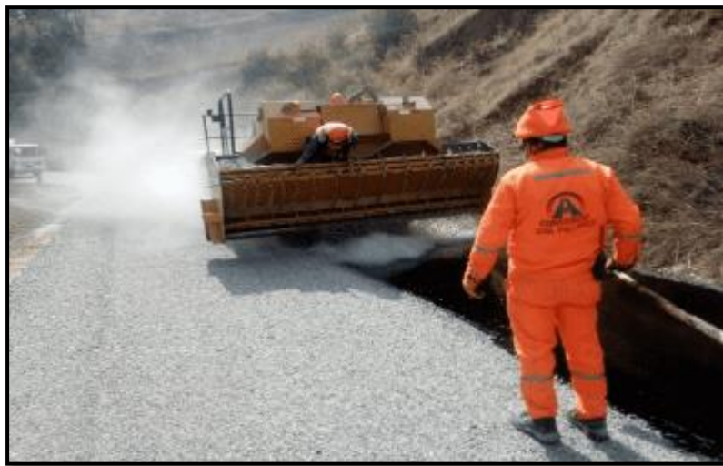
Figura 43: Esparcido de primera capa de agregado.
