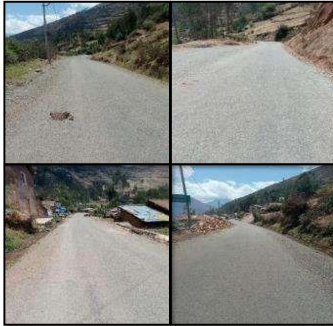
Figura 59: Etapa post PROG. 06+00 a 07+00.
