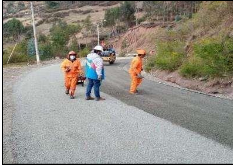
Figura 45: Compactación de primera capa de T.B.S.
