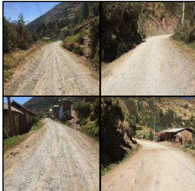
Figura 58: Etapa pre PROG. 06+00 a 07+00.
