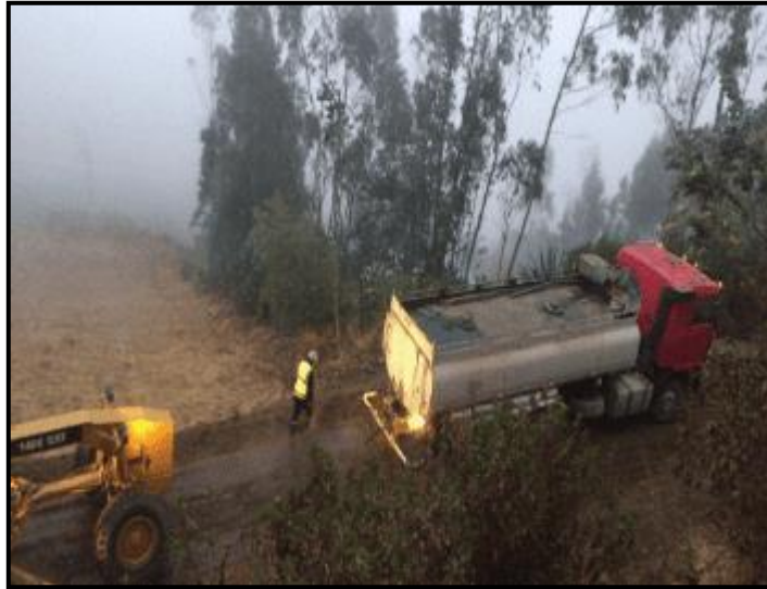
Figura 38: Riego y batido de emulsión asfáltica.
