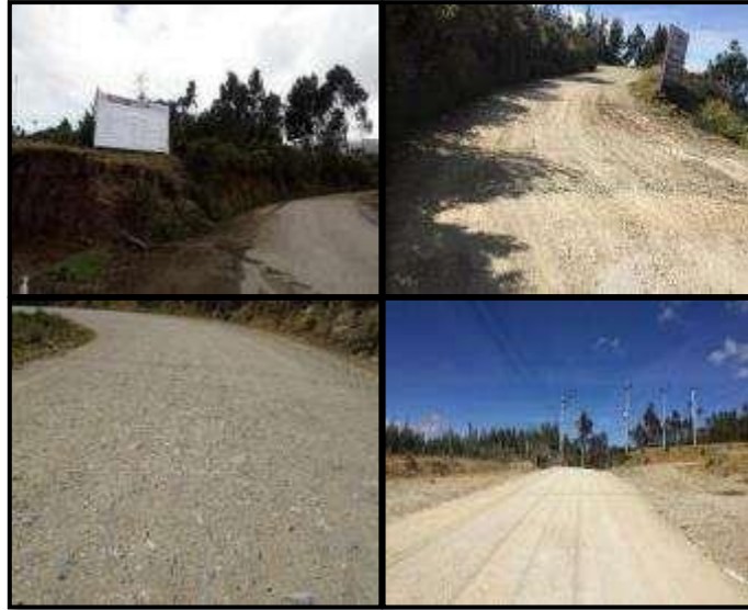
Figura 50: Etapa pre PROG. 00+00 a 01+00.
