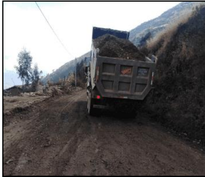
Figura 32: Transporte de material de cantera a obra.
