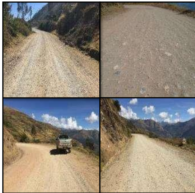
Figura 54: Etapa pre PROG. 02+00 a 03+00.
