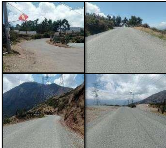
Figura 51: Etapa post PROG. 00+00 a 01+00.
