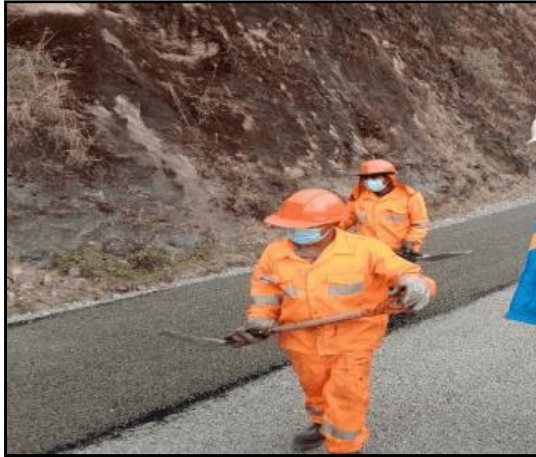
Figura 48: Colocación de segunda capa de agregado pétreo.
