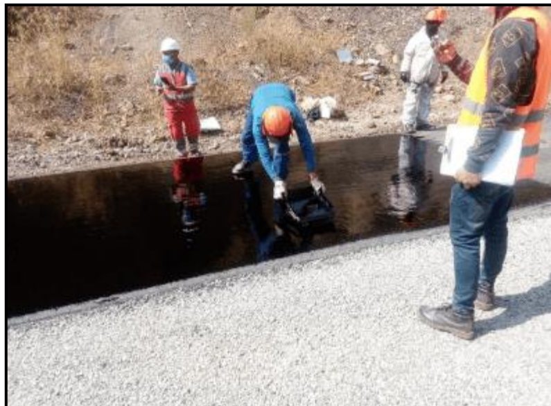
Figura 47: Segunda capa de emulsión para T.B.S.
