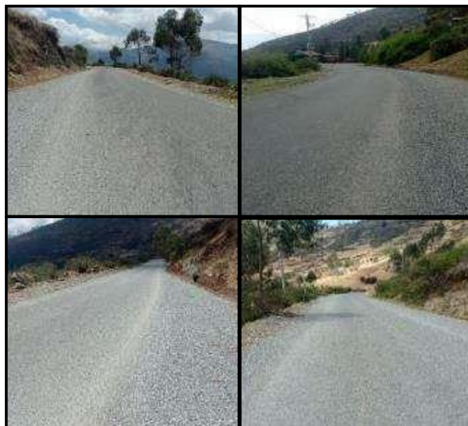
Figura 57: Etapa post PROG. 03+00 a 06+00.
