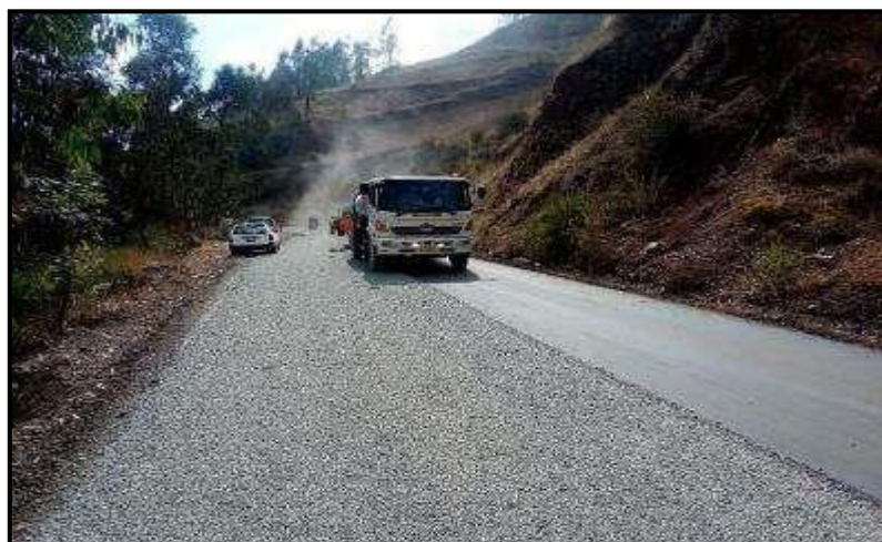
Figura 44: Esparcido de primera capa de agregado.
