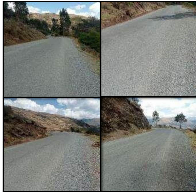
Figura 55: Etapa post PROG. 02+00 a 03+00..
