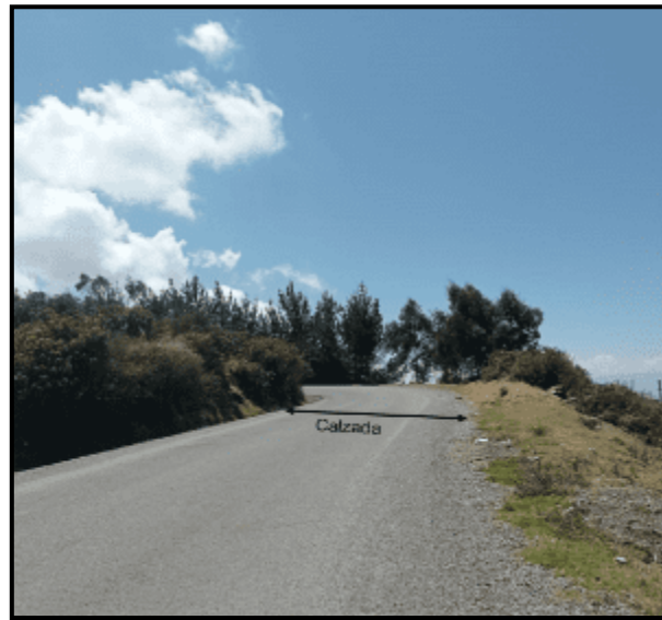
Figura 3: Calzada de la vía
