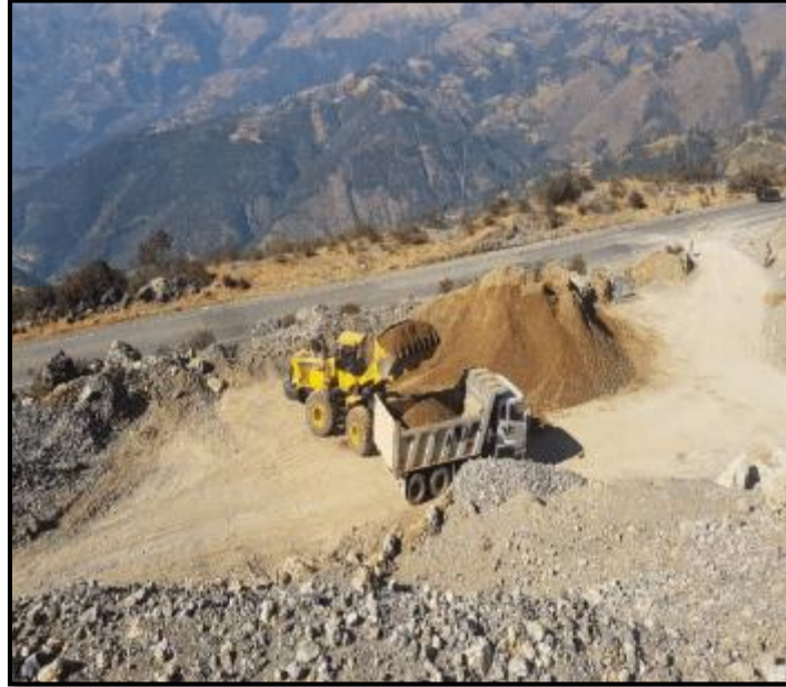
Figura 31: Acopio - carguío - traslado de material de cantera.
