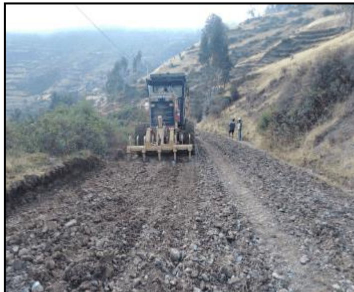
Figura 35: Escarificado de material de cantera
