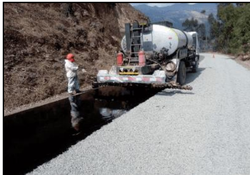
Figura 42: Riego de primera capa de emulsión asfáltica.
