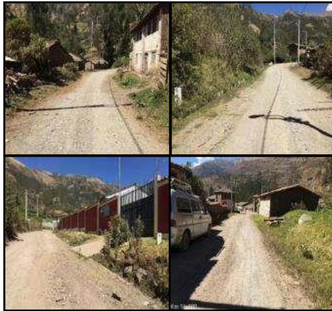
Figura 66: Etapa pre PROG. 13+00 a 15+660.
