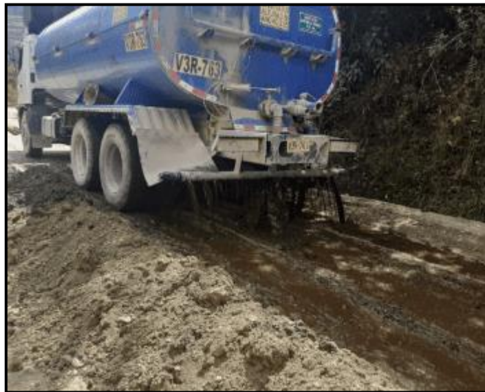
Figura 37: Riego de emulsión.
