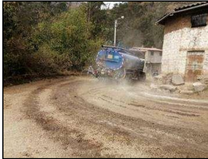
Figura 36: Riego de agua para optimo contenido de humedad.
