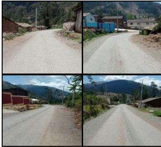
Figura 67: Etapa post PROG. 13+00 s 15+660.
