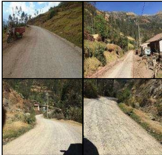
Figura 62: Etapa pre PROG. 10+00 a 11+00.
