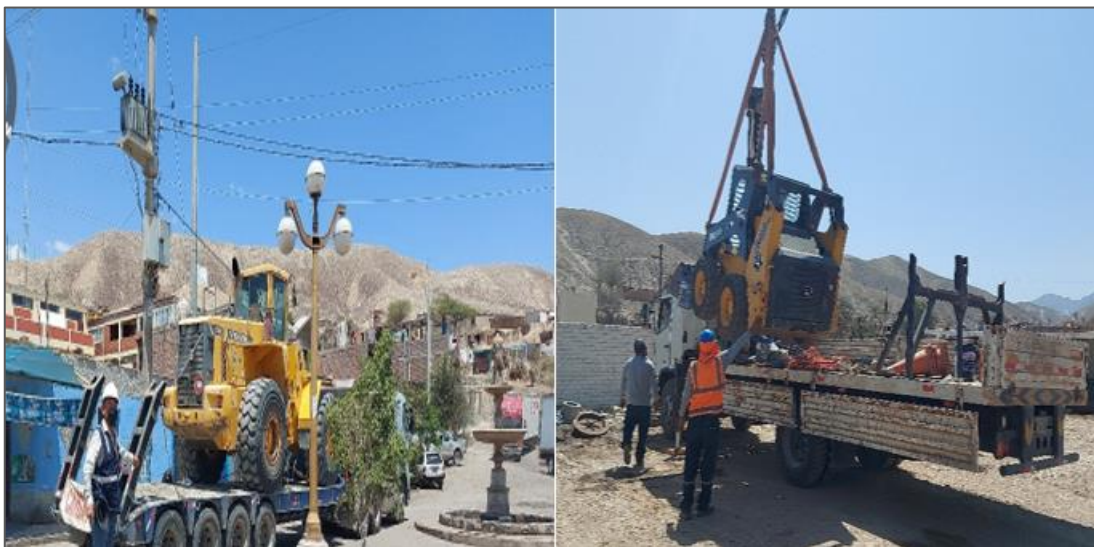
Movilización de maquinarias pesadas
