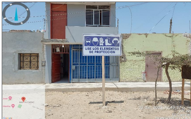
Oficina técnica de obra
