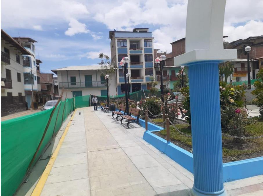
**Fotografía N° 1:** Se aprecia en la fotografía que el material no es de Adoquín, sino de concreto estampado
