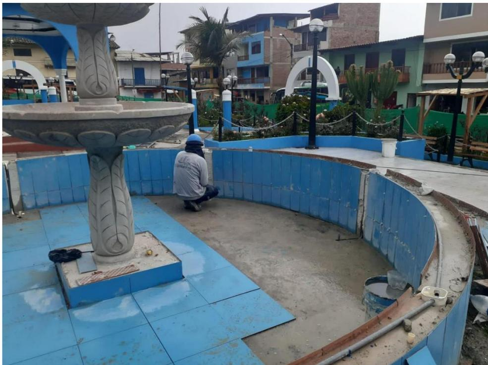
**Fotografía N° 7:** Se realizó trabajos de enchape en la pileta.
