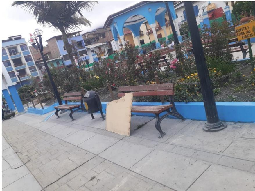
**Fotografía N° 2:** Se aprecia en la fotografía que tiene la forma de adoquín, pero es de concreto estampado
