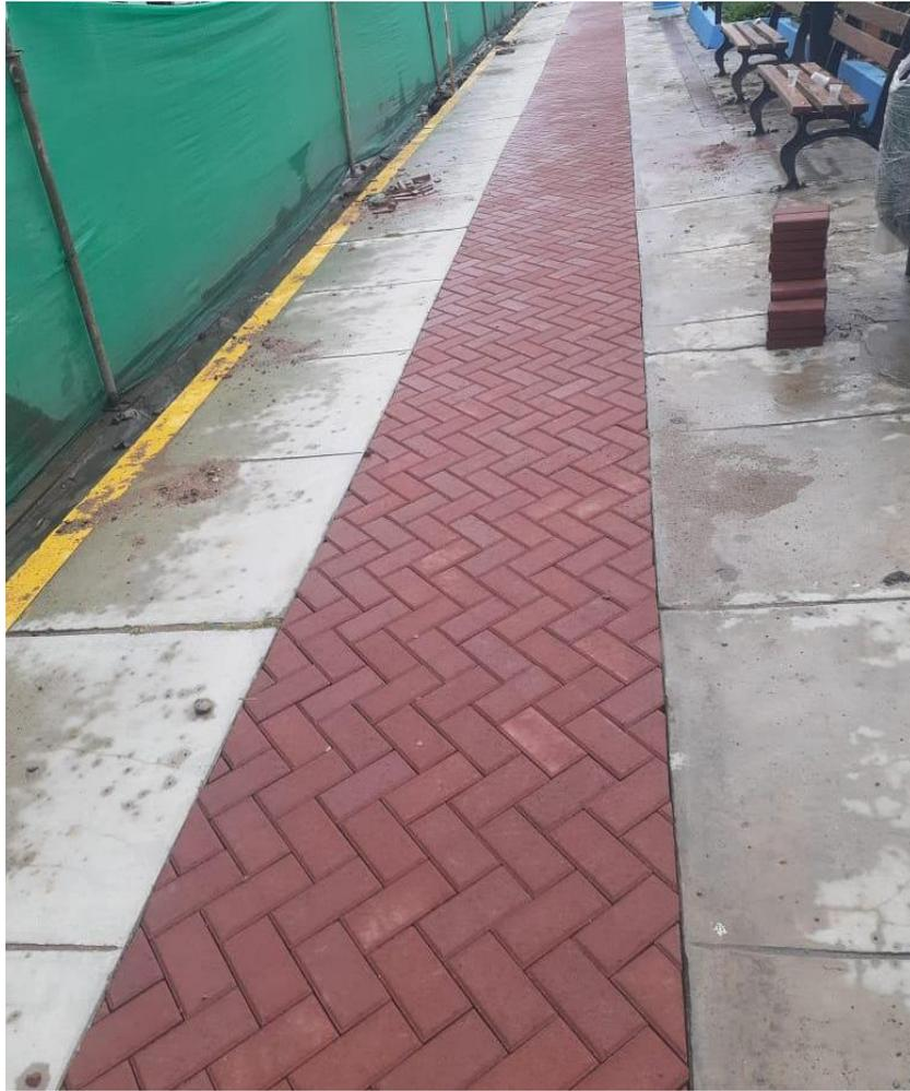
**Fotografía N° 8:** Se visualiza trabajo de adoquinado.
