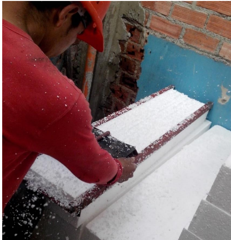
Figura 9: Aplicación de LA TÉCNICA DEL RASTRILLADO de bovedilla de poliestireno expandido
