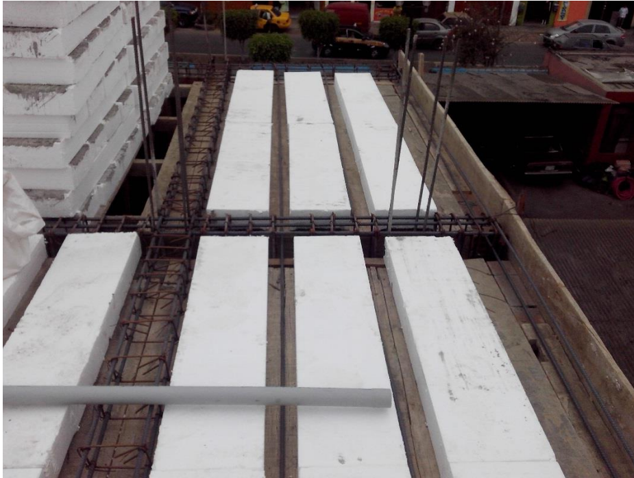
Figura 19: Vista del encofrado y la colocación de los casetones ya con morteros encima del encofrado.
