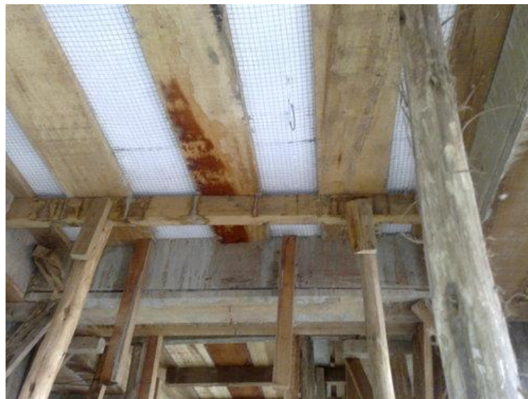
Figura 16: Procedimiento constructivo de enlucido de cielorraso del METODO “B”.
