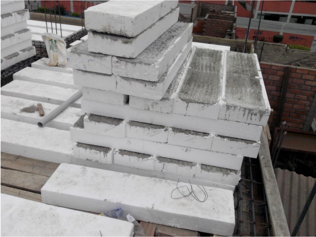
Figura 11: Figura de bovedillas de poliestireno expandido ya secas y listas para colocar en el encofrado de la losa aligerada.
