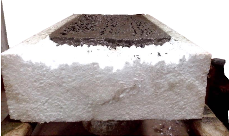
Figura 10: Colocado del mortero cemento arena gruesa, al ras de la superficie de la bovedilla
