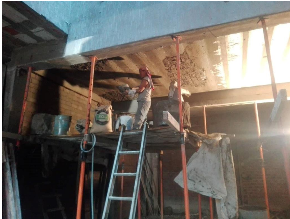
Figura 15. Procedimiento constructivo de enlucido de cielorraso del METODO “A”.
