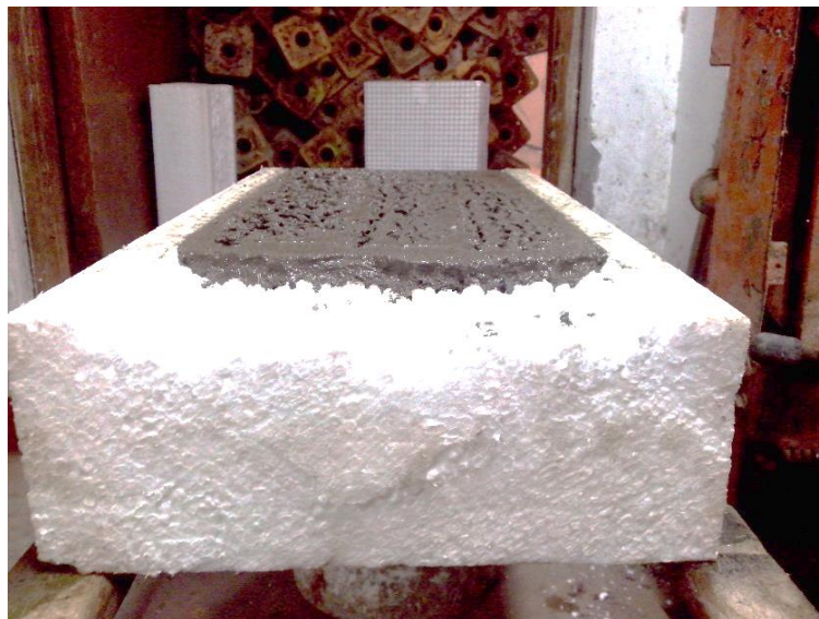
Figura 18: Colocación del mortero en los canelos hasta enrasar la superficie del casetón
