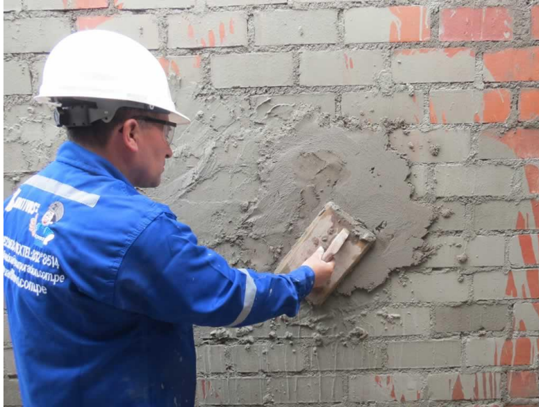
Figura 5: Enlucido o mayormente llamado tarrajeo.
