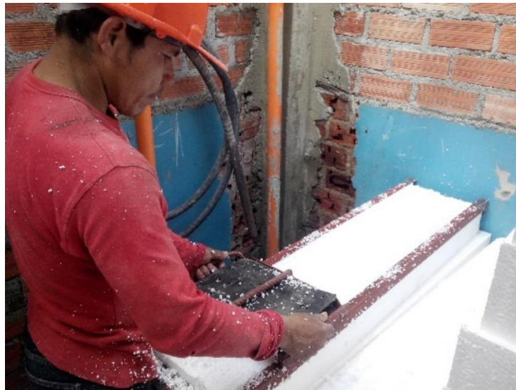
Figura 8: Herramienta hechiza para el rasgado de la bovedilla de poliestireno expandido.
