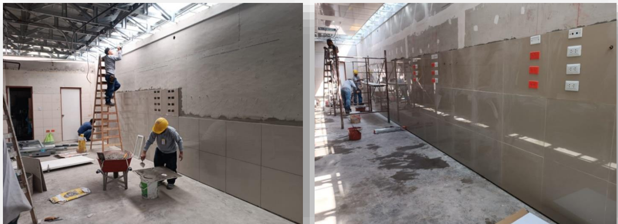
Figura 19. Instalación de zócalo de porcelanato de 0.60x0.60m h=1.80m
