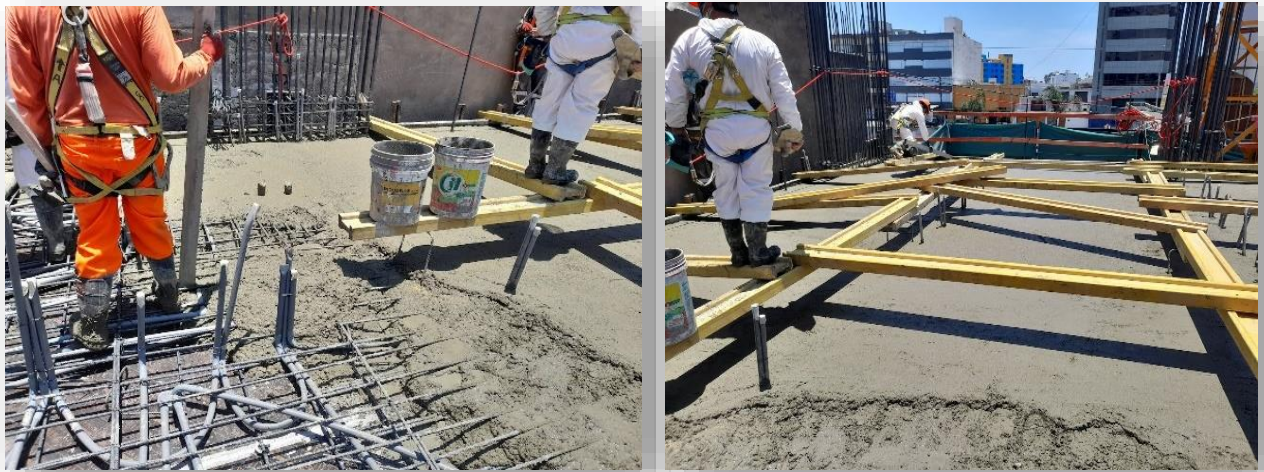
Figura 8. Vertido de concreto en elementos verticales y horizontales
