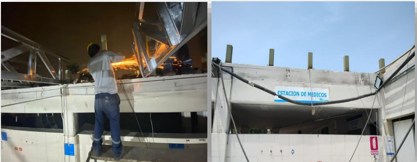
Figura 13. Instalación de columnas metálicas para base de tijerales
