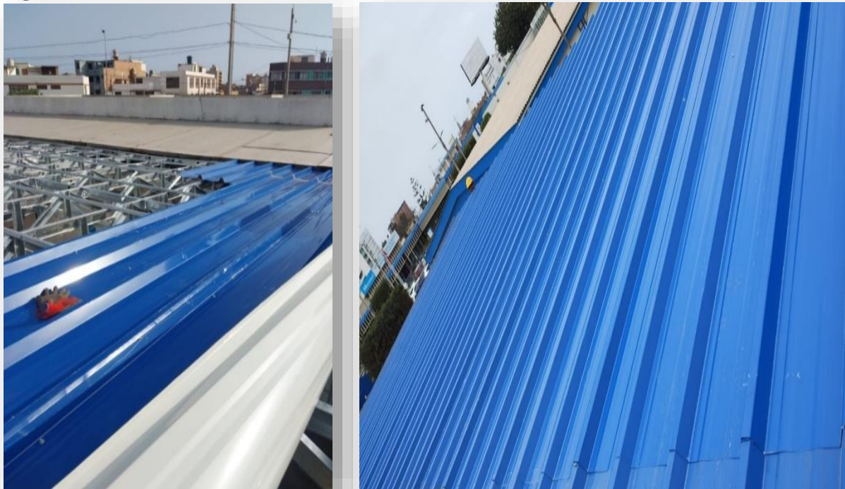
Figura 15. Instalación de cobertura de aluzinc
