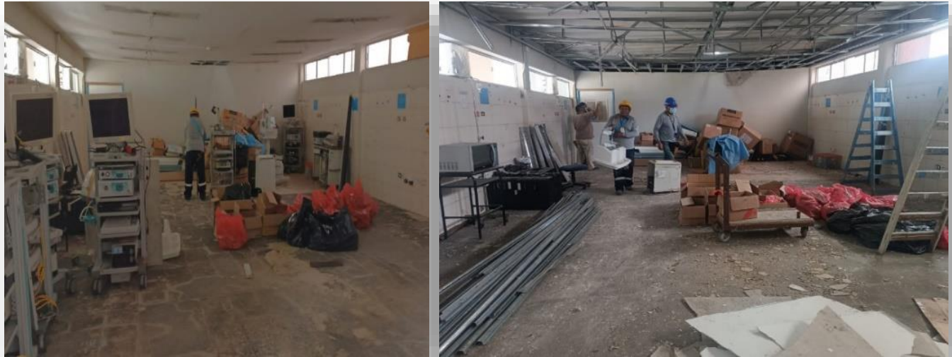
Figura 9. Picado de piso vinílico de 0.40x0.40m (Incluye picado de pegamento asfáltico)
