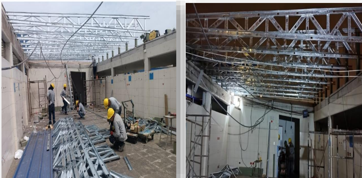
Figura 14. Instalación de vigas principales y omegas (doble turno)
