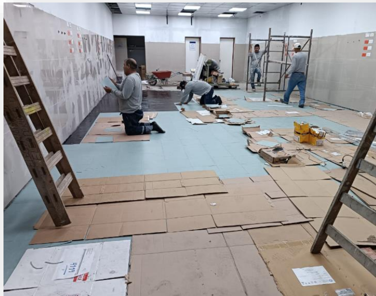
Figura 20. Masillado y empastado de muros interiores h=0.90m
