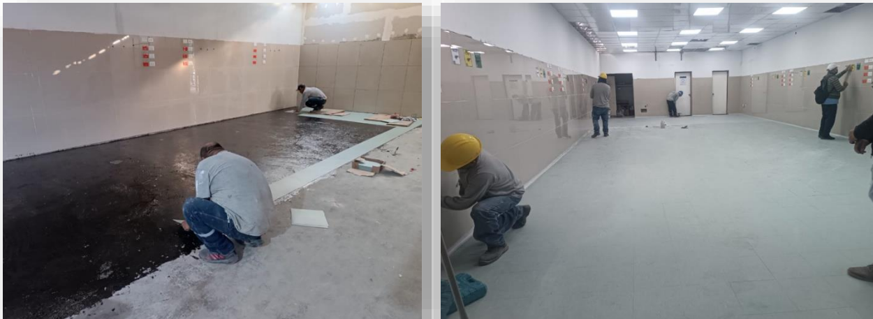
Figura 21. Colocación de piso de vinílico de 0.40x0.40
