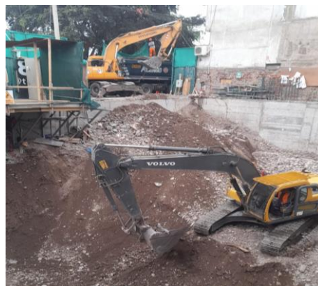
Figura 5 Excavación y eliminación del segundo anillo
