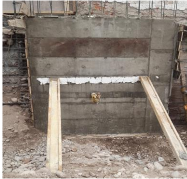
Figura 17 Relleno de material o apuntalamiento
