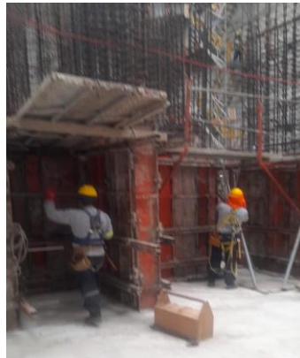
Figura 31 Desencofrado de placas
