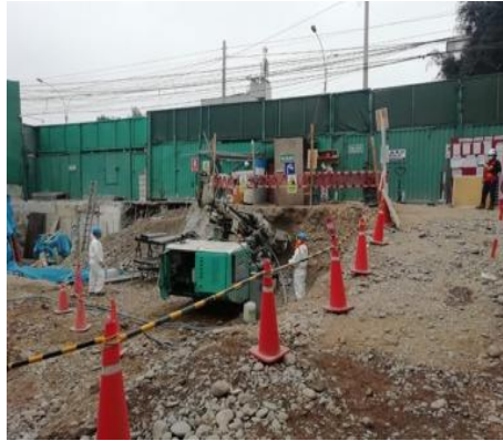
Figura 9 Perforación e inyección del primer anillo
