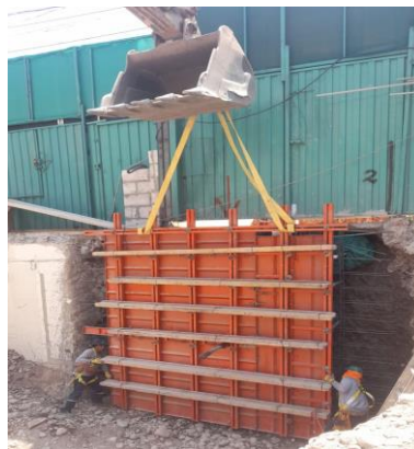
Figura 12 Encofrado metálico en muros
