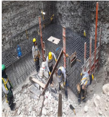
Figura 23 Encofrado de cimentaciones
