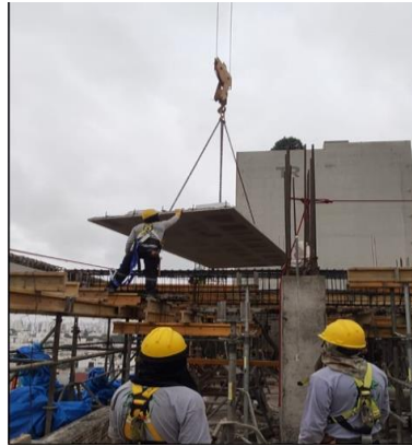
Figura 36 Colocación de prelosas
