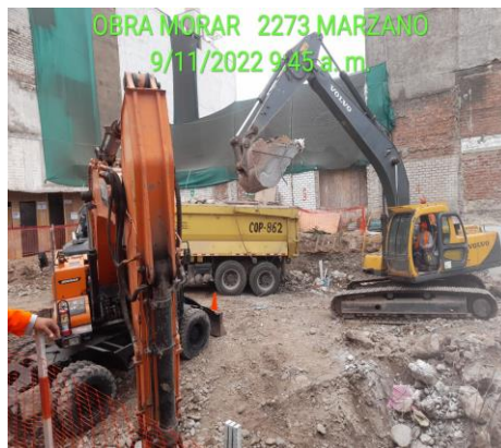
Figura 4 Excavación y eliminación del primer anillo
