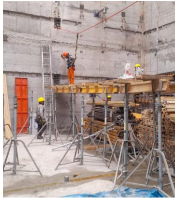
Figura 32 Apuntalamiento y encofrado de vigas
