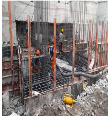
Figura 24 Vaciado de concreto en cimentaciones
