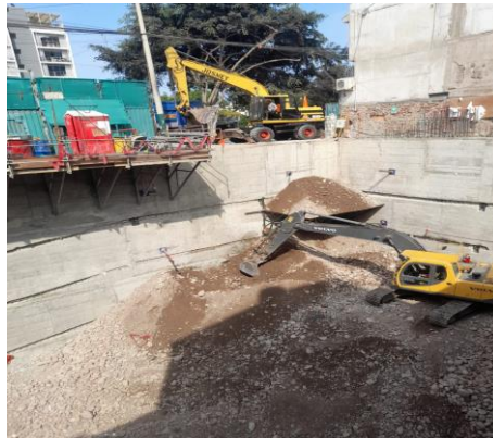
Figura 7 Excavación y eliminación del cuarto anillo
