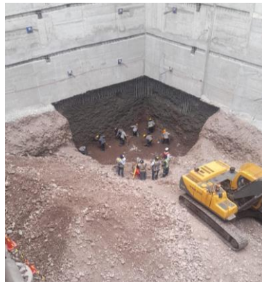
Figura 20 Perfilamiento manual
