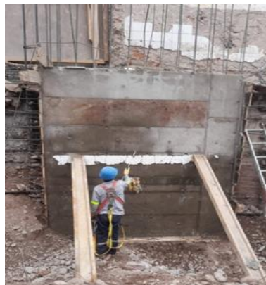
Figura 16 Curado de muros
