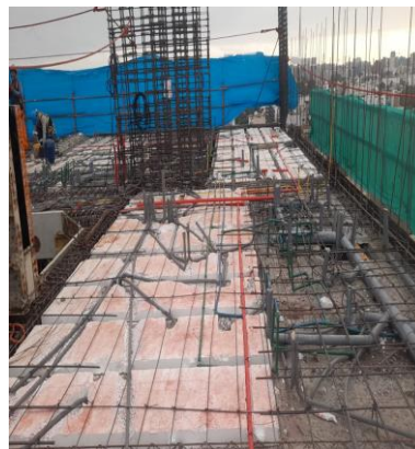
Figura 37 Colocación de acero en prelosas
