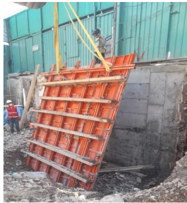
Figura 15 Desencofrado metálico de muros
