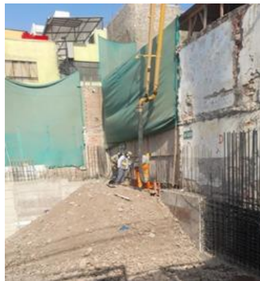
Figura 14 Vaciado de concreto
