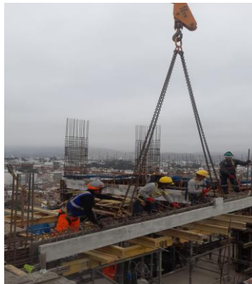
Figura 33 Apuntalamiento de previga
