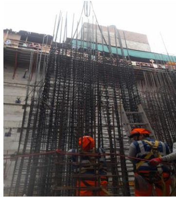
Figura 28 Armado y colocación de acero en placas
