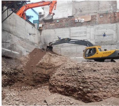
Figura 6 Excavación y eliminación del tercer anillo
