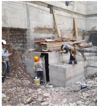
Figura 25 Desencofrado y aplicación de alquitrán en cimentaciones
