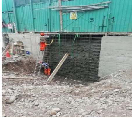
Figura 11 Habilitación y colocación de acero
