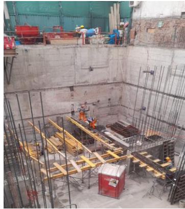
Figura 34 Colocación de acero de viga convencional
