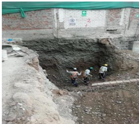
Figura 10 Perfilado de paños manual y con maquinaria
