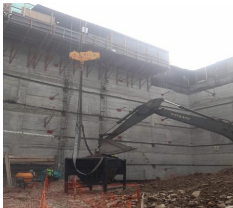
Figura 8 Excavación y eliminación del cuarto anillo
