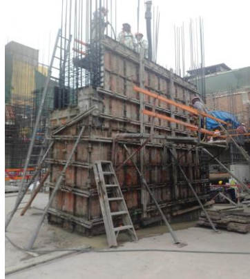
Figura 30 Vaciado de concreto de placas
