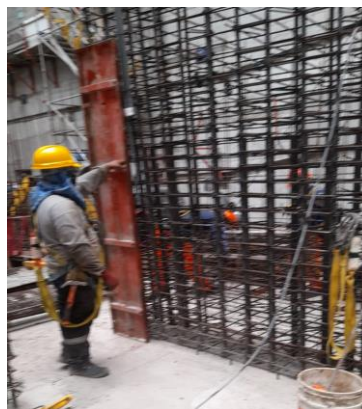
Figura 29 Encofrado de placas
