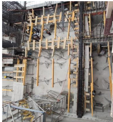
Figura 35 Apuntalamiento de prelosas
