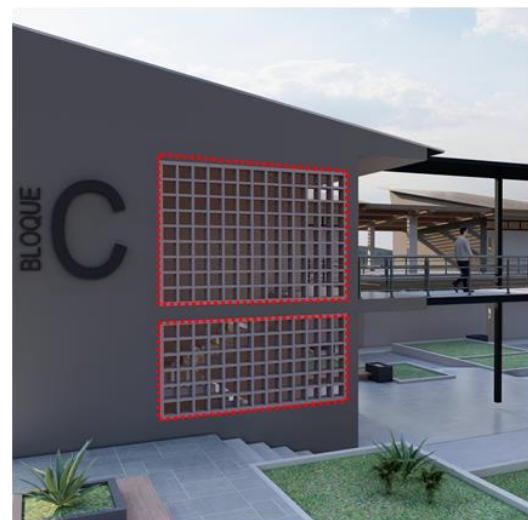
Cerramientos (celosías de concreto) en la escalera.
