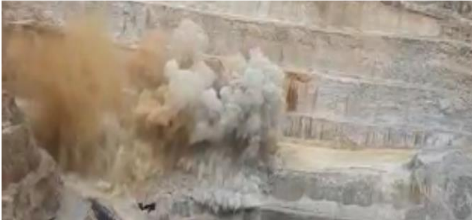
FOTO 5: Iniciación del proceso de voladuras.
