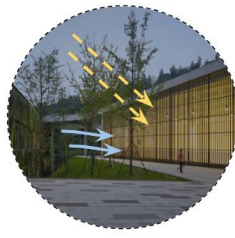
VENTANALES HORIZONTALES CONTROLANDO EL INGRESO DE ILUMINACIÓN CON PARASOLES VERTICALES.
