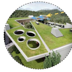
USO DE TEATINAS PARA EL INGRESO DE ILUMINACIÓN CENTRAL.
