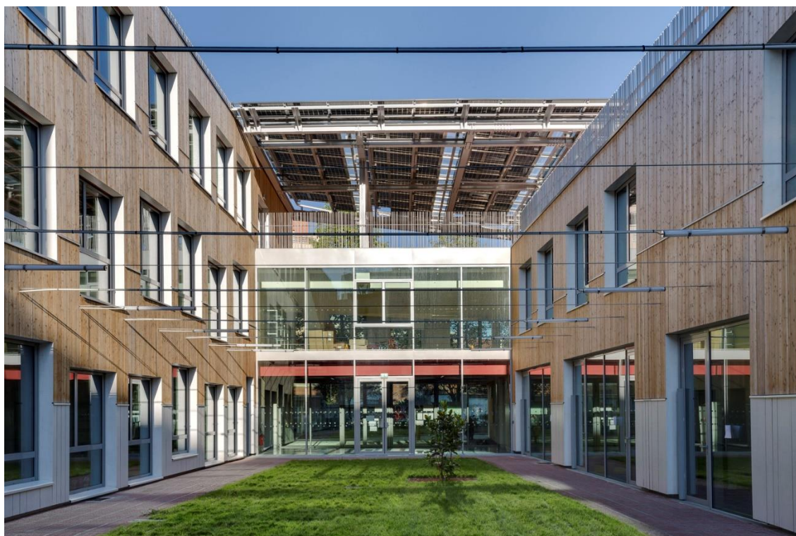
Figura 28. Vista del patio interno de la Escuela Zero Energía, Francia.
