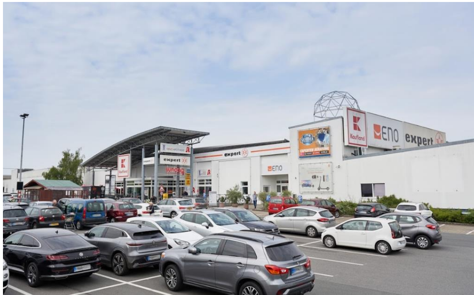
Figura 20. Vista del estacionamiento del Centro Comercial Nordhorn
