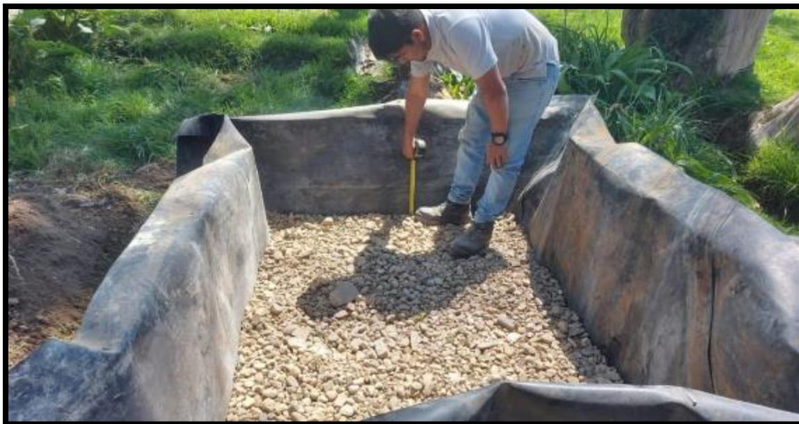
*Nota: La grava de 1" debe medir 5 cm de profundidad según las indicaciones del plano del Humedal Artificial.*
