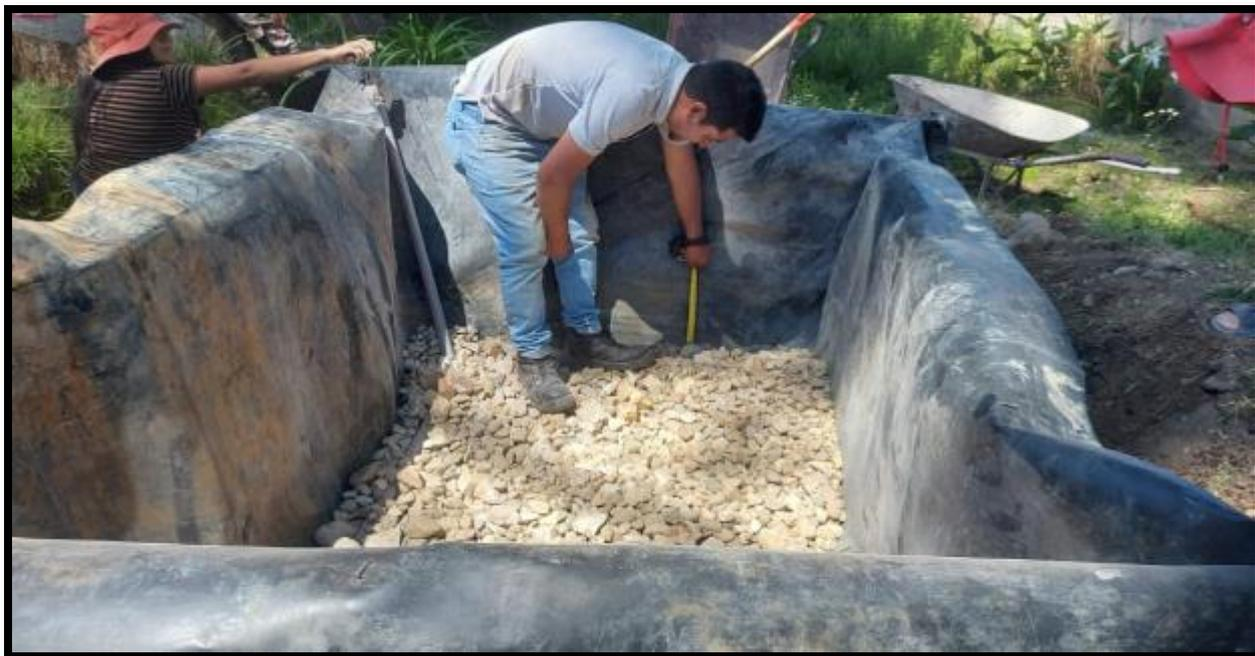
*Nota: La grava de 1/2" debe medir 5 cm de profundidad según las indicaciones del plano del Humedal Artificial*
