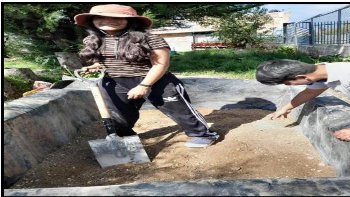
*Nota: La arena debe medir 3 cm de profundidad según las indicaciones del plano del Humedal Artificial*
