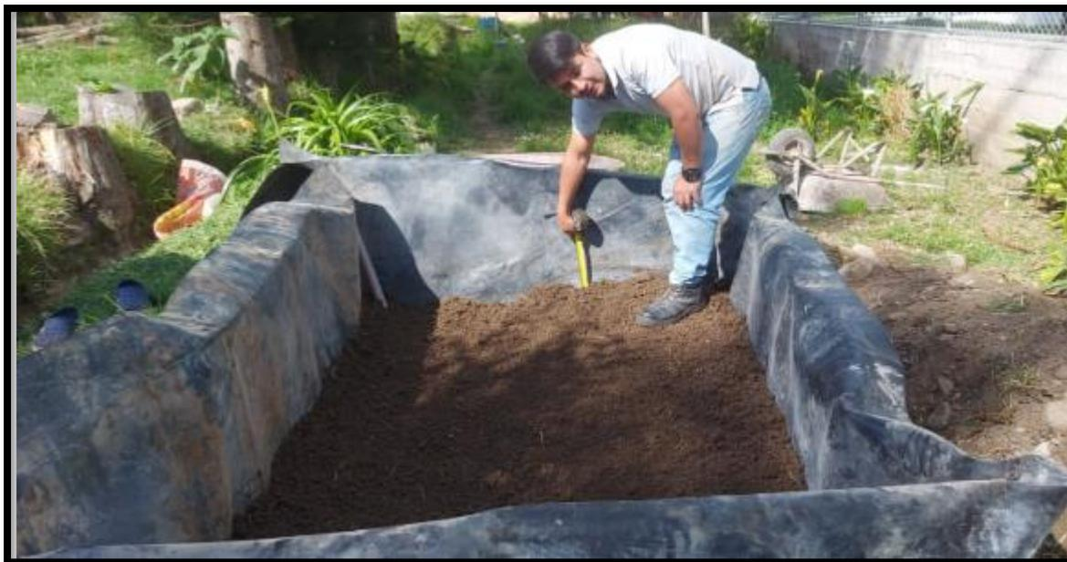
*Nota: según las indicaciones del plano del Humedal Artificial el lodo debe medir 7 cm de profundidad*
