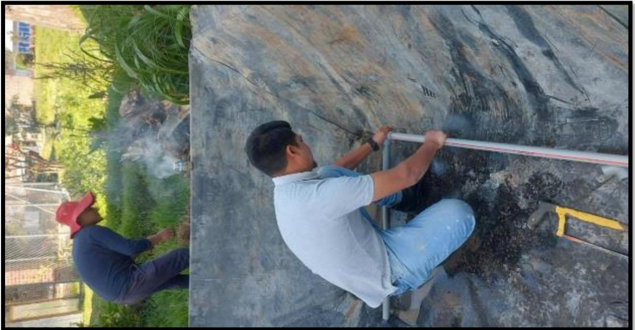
*Nota: Instalación de tubería de 1" en el Humedal Artificial*
