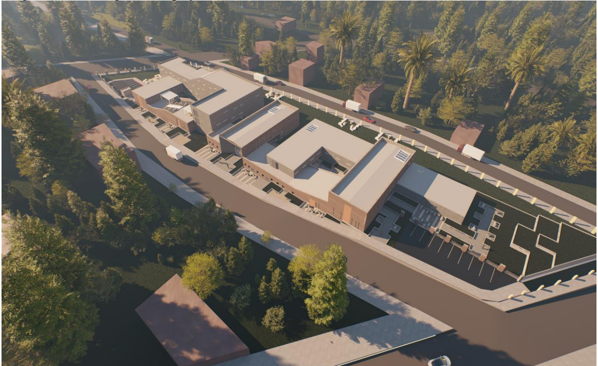
Figura 10.13. vista general del proyecto
