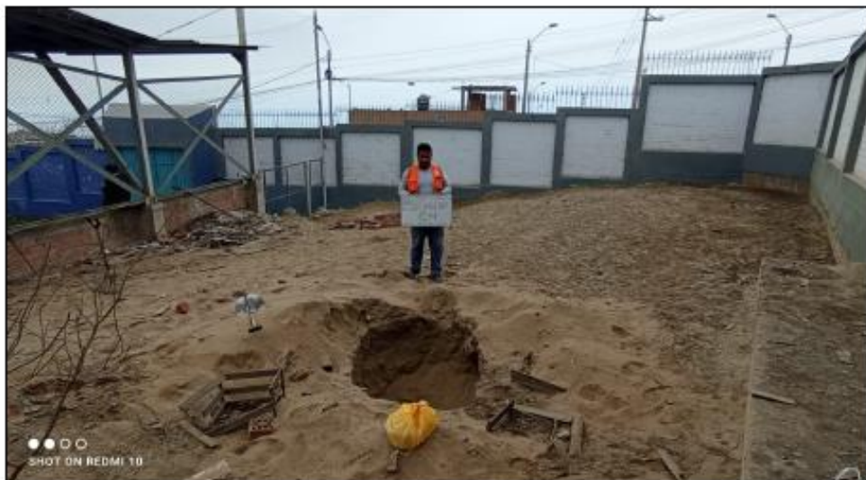
FOTO N° 14: Otra vista panorámica exterior de la excavación a cielo abierto denominada calicata C-4.
