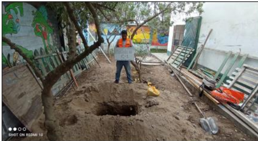
FOTO N° 2: Otra vista panorámica exterior de la excavación a cielo abierto denominado calicata C-1.
