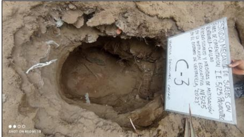
FOTO N° 11: Vista interior de la calicata C-3 donde se muestra el proceso de excavación y el perfil estratigráfico del subsuelo.
