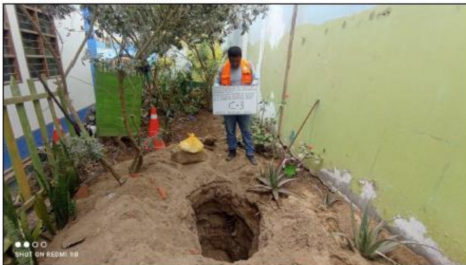
FOTO N° 10: Otra vista panorámica exterior de la excavación a cielo abierto denominada calicata C-3.
