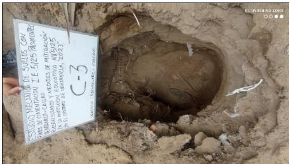
FOTO N° 12: Vista interior de la calicata C-3 donde se muestra el perfil estratigráfico del subsuelo. Se alcanzó una profundidad de exploración de 2.00m. No se encontró la presencia de nivel freático a dicha profundidad.
