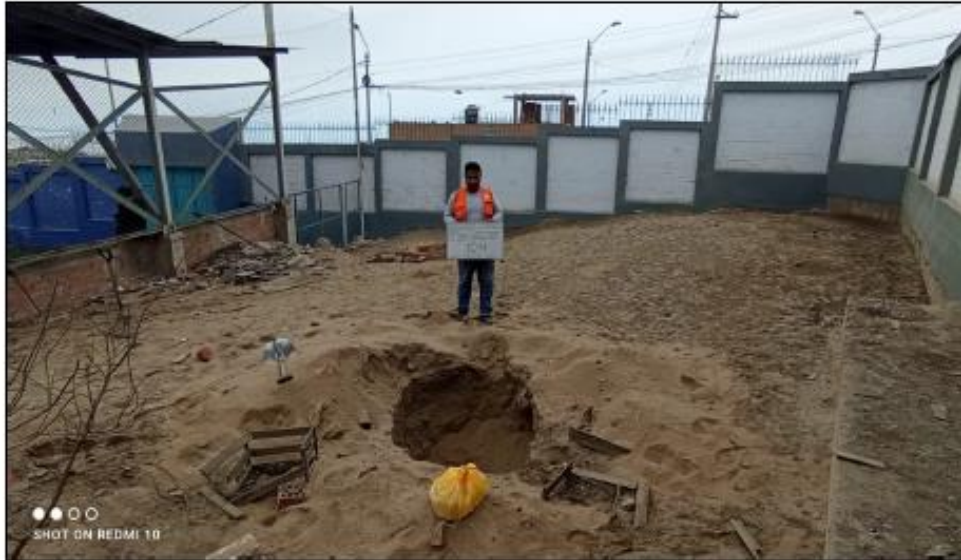
FOTO N° 13: Vista panorámica exterior de la excavación a cielo abierto denominada calicata C-4.
