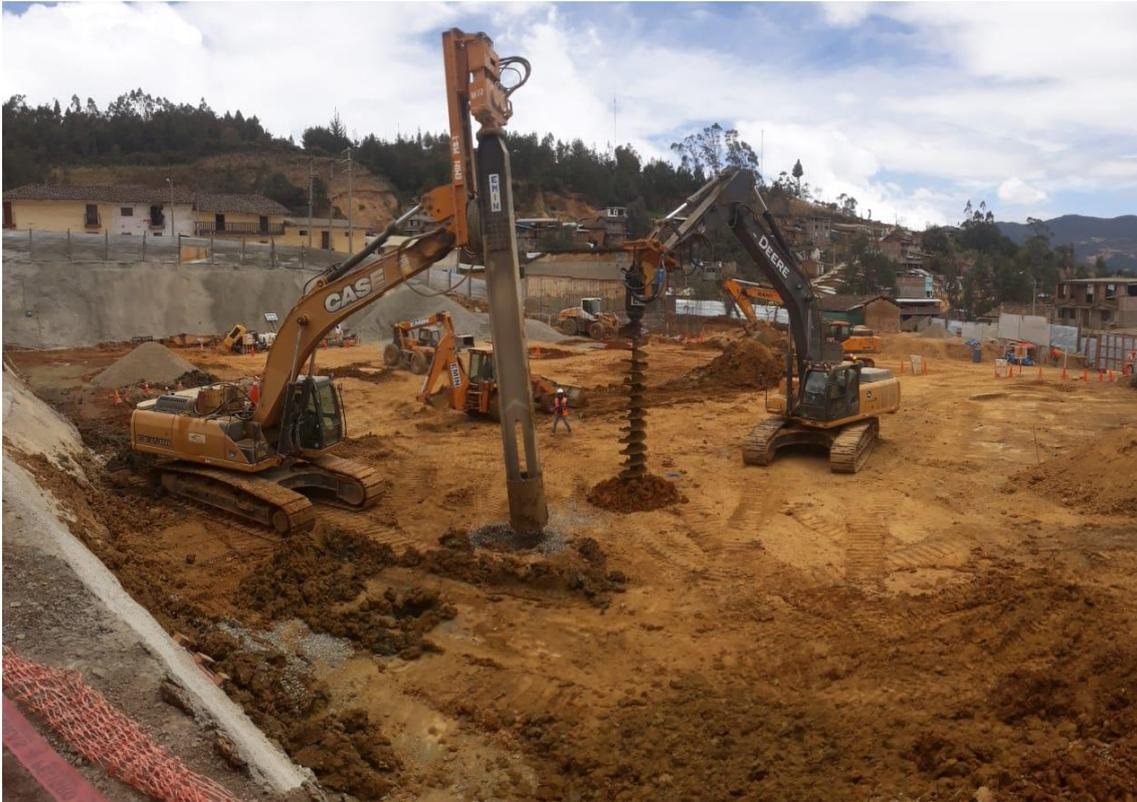
Foto: Trabajos de construcción de pilas de gravas en el bloque principal del Hospital de Ayabaca.
