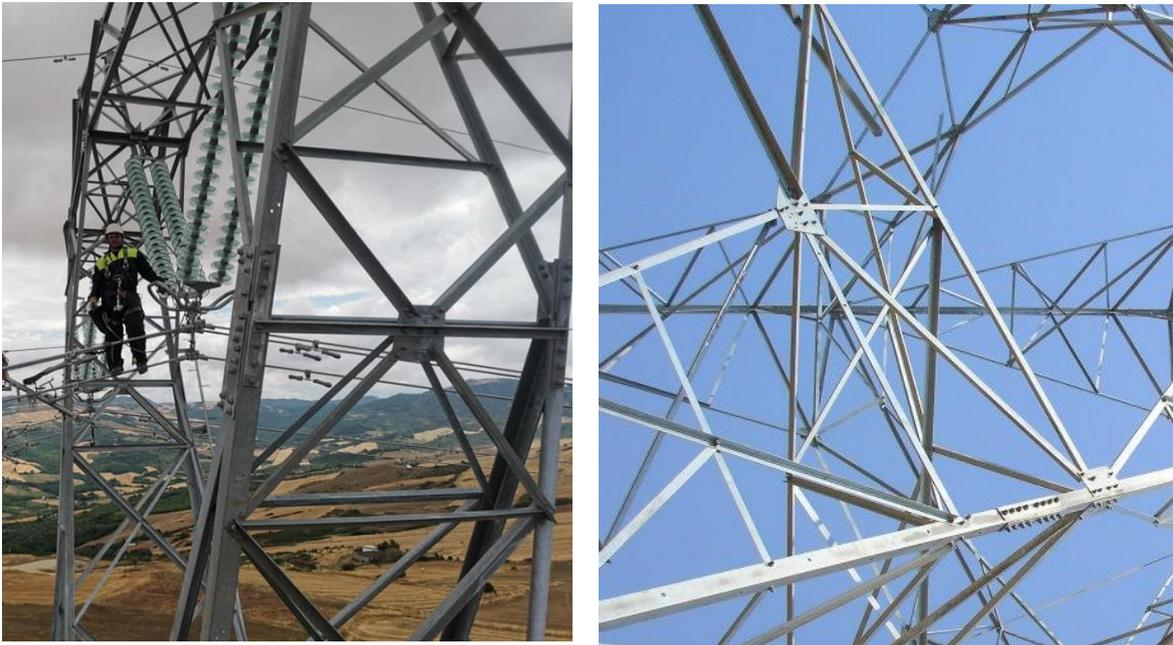
Nota: Visualización de nodos o uniones de una torre de transmisión en construcción.
